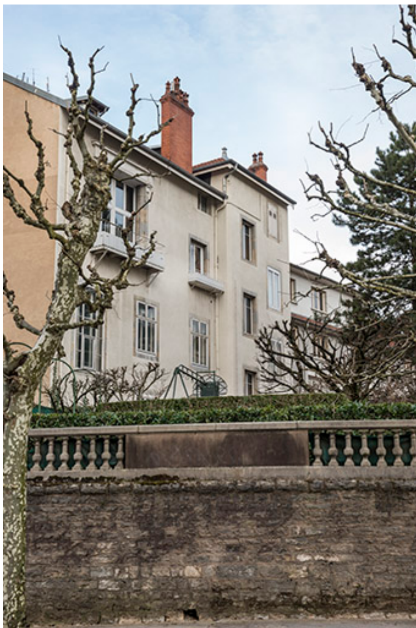
Façade postérieure, depuis l'avenue Denfert-Rochereau.
