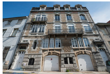
Façade antérieure. Vue en contre-plongée. Phot. Jérôme Mongreville IVR43_20172501123NUC4A
