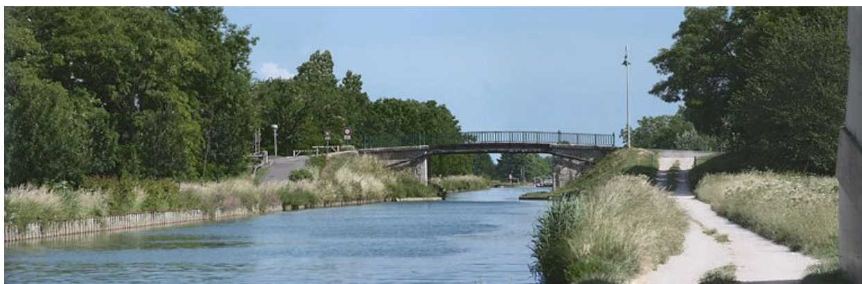
Vue d'aval, le pont dans son environnement.
