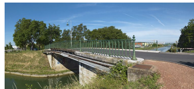
Vue rapprochée : le garde-corps ancien. Phot. Thierry Kuntz IVR26_20112103005NUC4A
