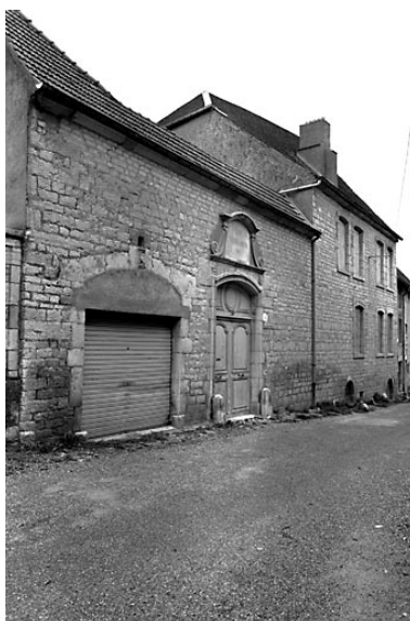
Façade sur rue. Phot. Dominique Dominguez IVR43_19807000553X
