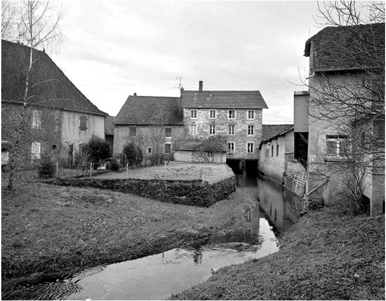
Vue d'ensemble.Façade postérieure.
