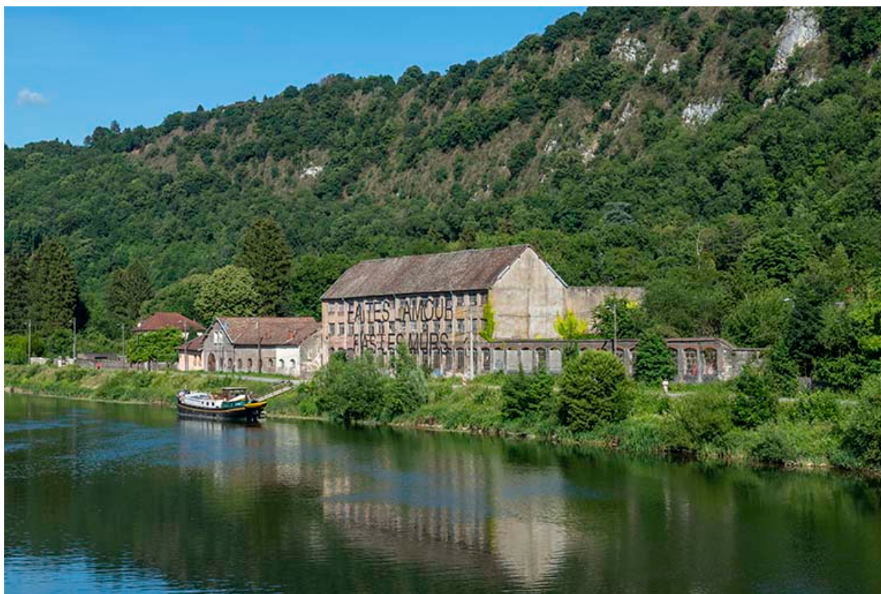
Vue rapprochée depuis l'ouest.
