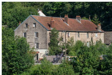
Logement ouvrier. Vue depuis le nord-ouest. Phot. Jérôme Mongreville IVR43_20182501275NUC4A
