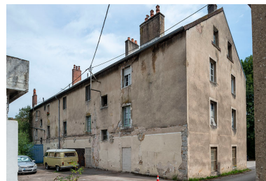
Logement ouvrier vu de trois quarts arrière. Phot. Jérôme Mongreville IVR43_20182501290NUC4A
