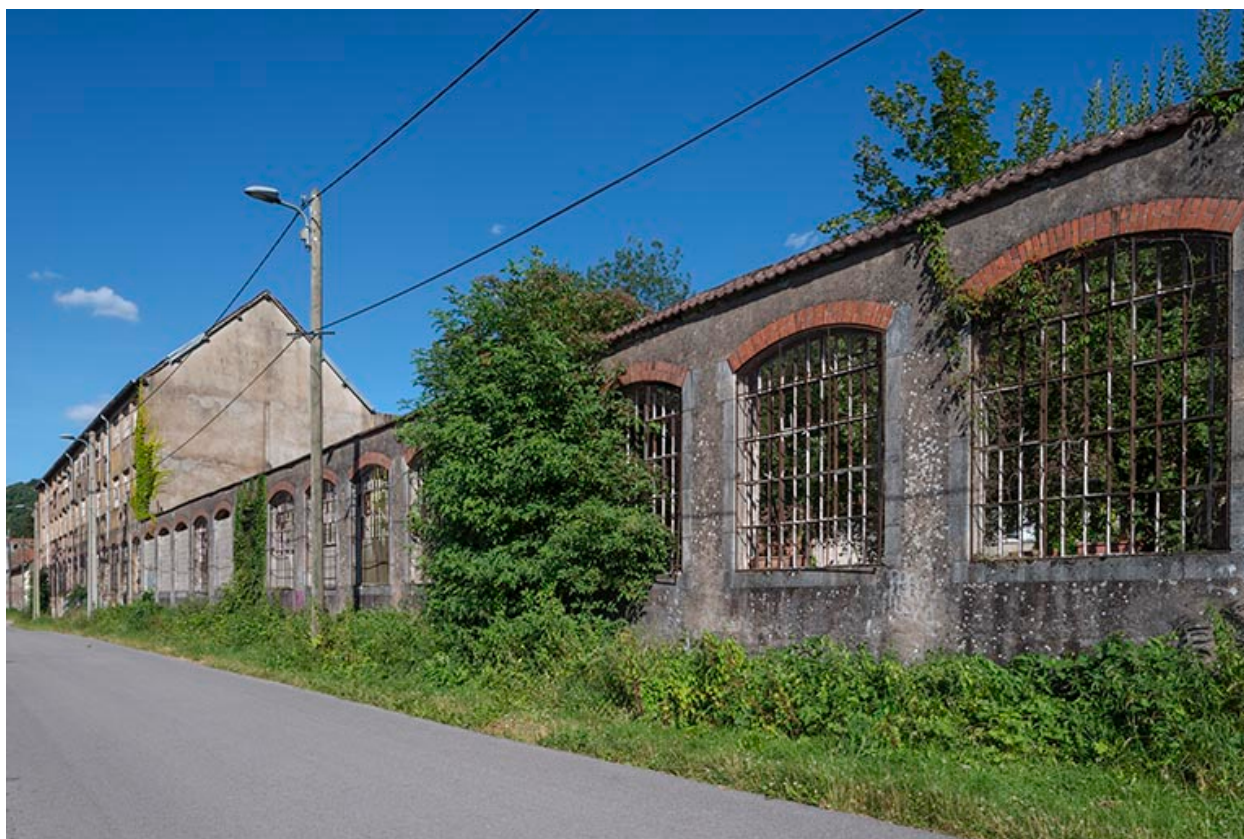
Atelier de fabrication (et vestiges) le long du chemin de halage.
