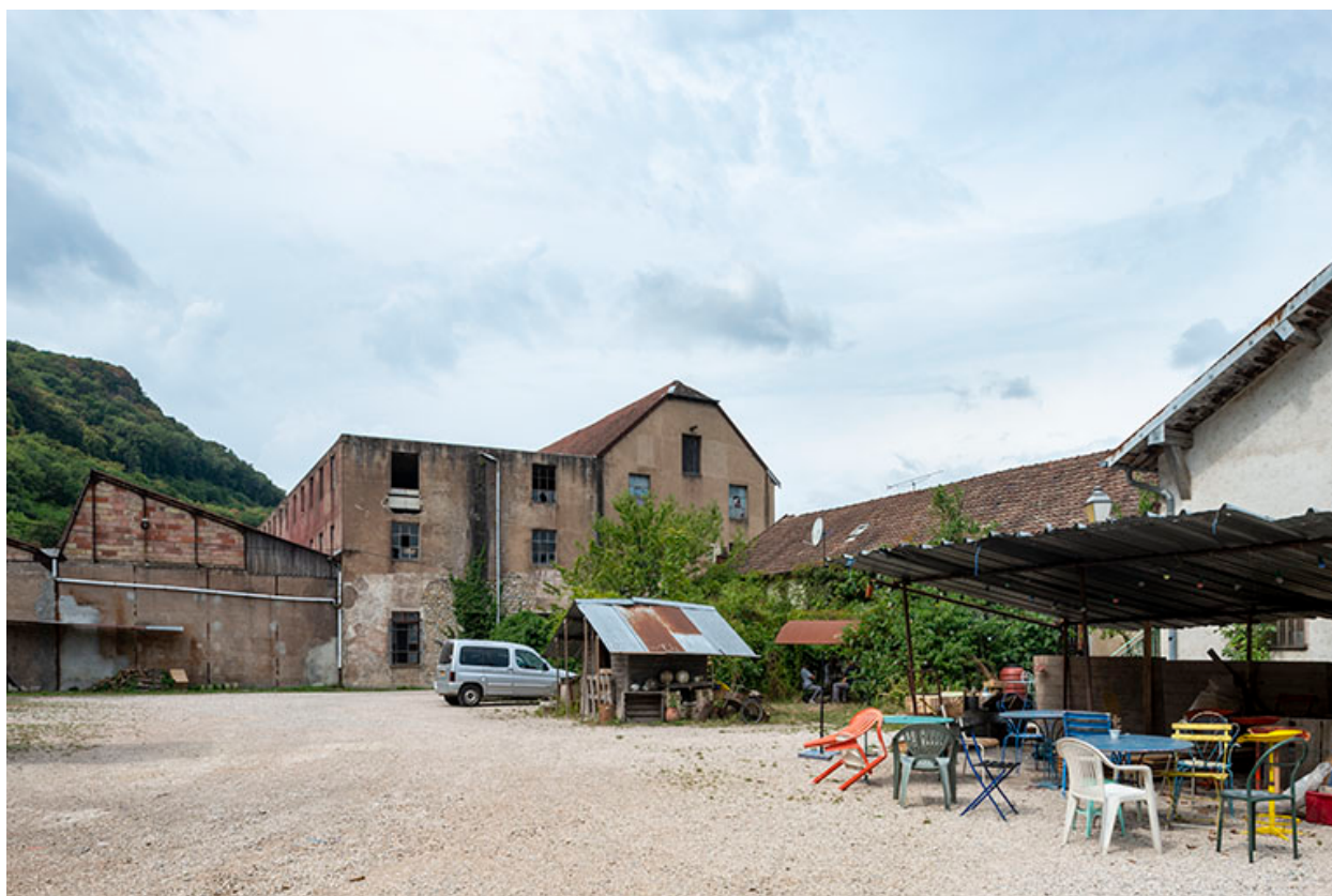
Ateliers de fabrication depuis la cour de la faïencerie.
