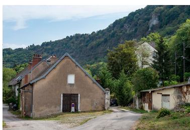
Ecurie et remises depuis l'ouest. Phot. Jérôme Mongreville
