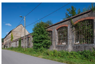
Atelier de fabrication (et vestiges) le long du chemin de halage. Phot. Jérôme Mongreville IVR43_20182501276NUC4A
