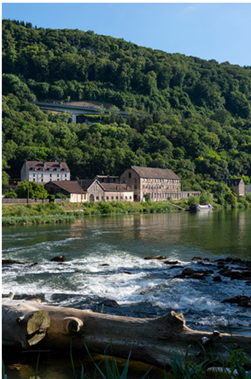
Vue d'ensemble depuis le nord-est (cadrage vertical).
