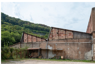
Murs-pignons des ateliers. Phot. Jérôme Mongreville IVR43_20182501296NUC4A
