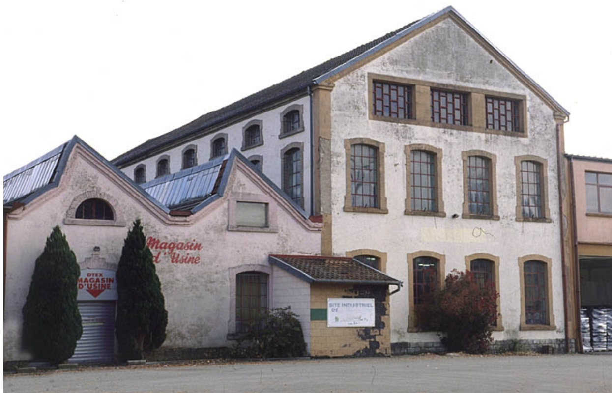
Pignons des façades antérieures.
