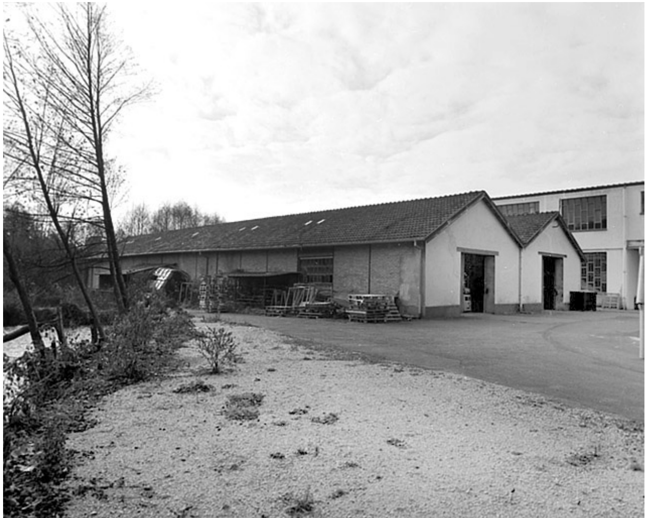
Magasin ou entrepôt industriel (?).
