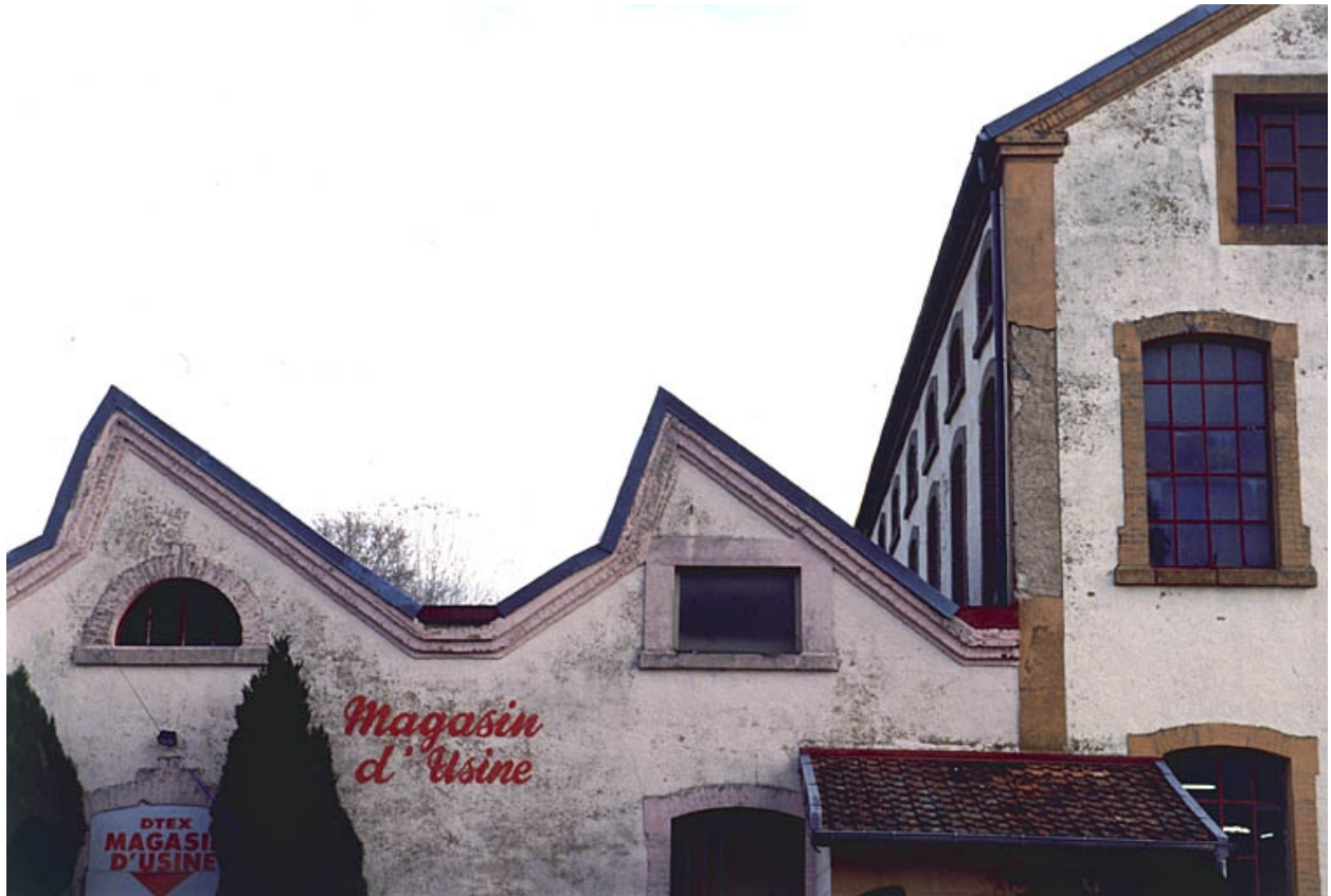
Détail des pignons.
