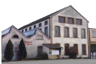
Pignons des façades antérieures.
