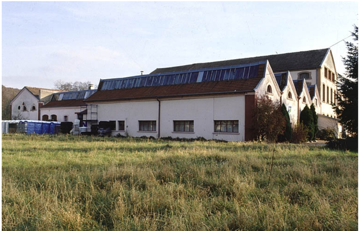
Vue de trois quarts depuis l'ouest.
