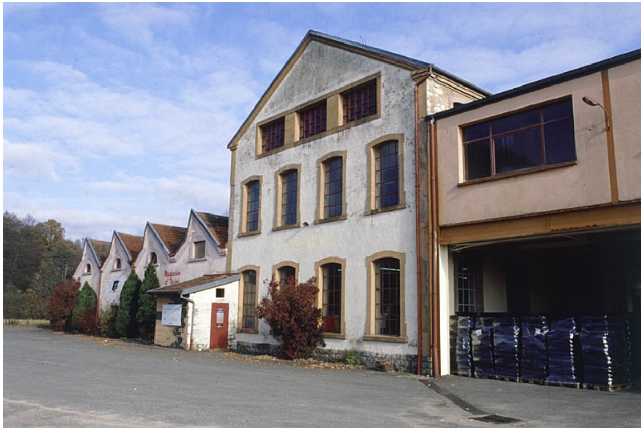
Façades antérieures depuis le sud.
