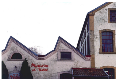
Détail des pignons.
