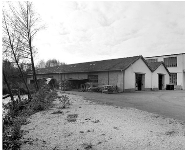
Magasin ou entrepôt industriel (?).
