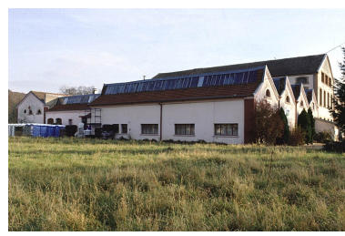
Vue de trois quarts depuis l'ouest.
