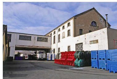
Façade postérieure des ateliers de fabrication.
