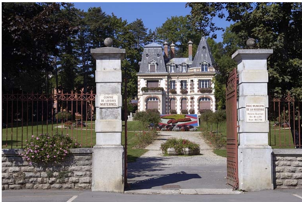
Vue d'ensemble depuis l'entrée du parc.
