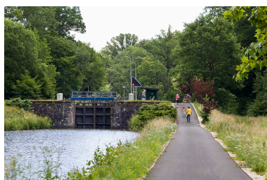
Vue d'ensemble depuis l'aval. Phot. Sonia Dourlot IVR43_20157000916NUC2A
