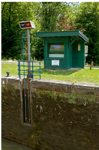
Le poste de commande. Phot. Sonia Dourlot IVR43_20157000919NUC2A
