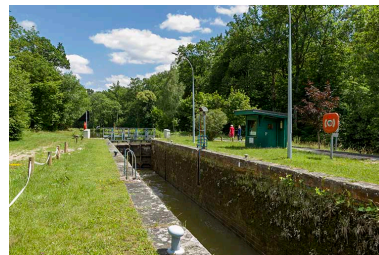
L'écluse et son sas. Phot. Sonia Dourlot IVR43_20157000918NUC2A
