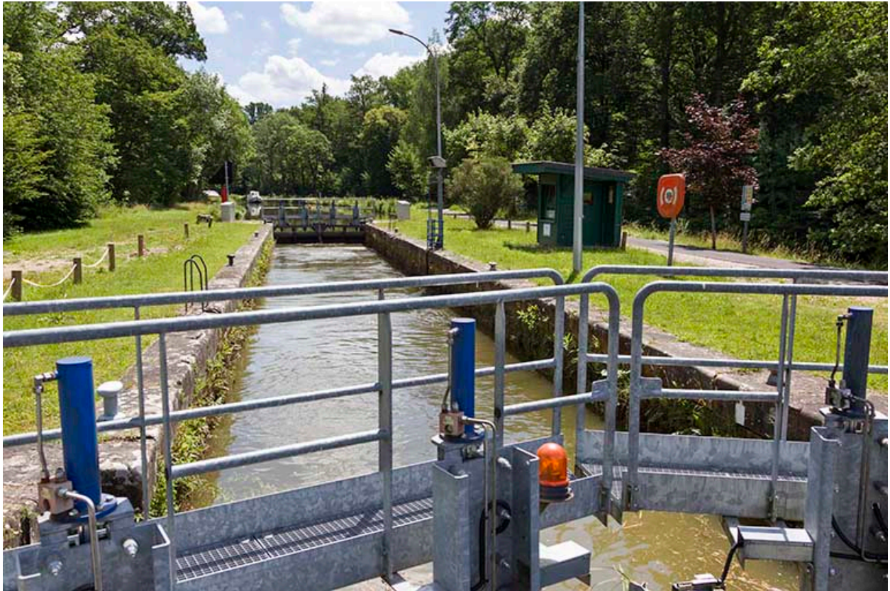
L'écluse, depuis la passerelle.
