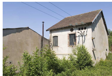
Bâtiment d'eau, actuellement transformateur. Phot. Jérôme Mongreville IVR43_20097000295NUC2A
