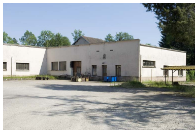
Partie sud de l'usine. Phot. Jérôme Mongreville IVR43_20097000292NUC2A
