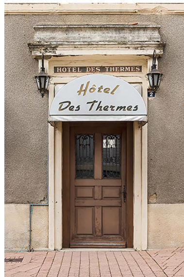
Porte d'entrée. Phot. Pierre-Marie Barbe-Richaud IVR26_20227100033NUC4A
