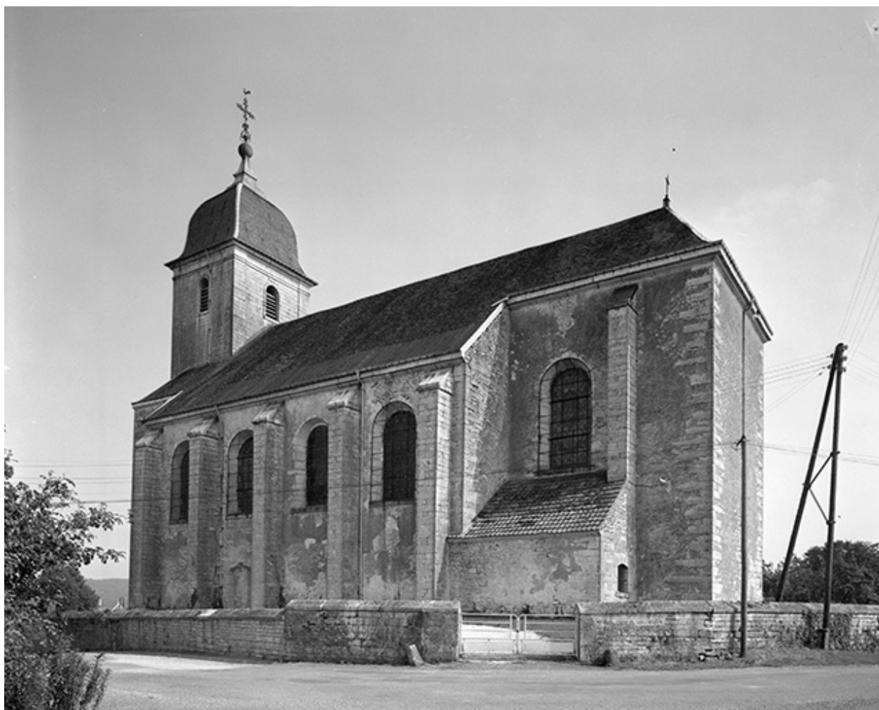
Façade latérale droite.
