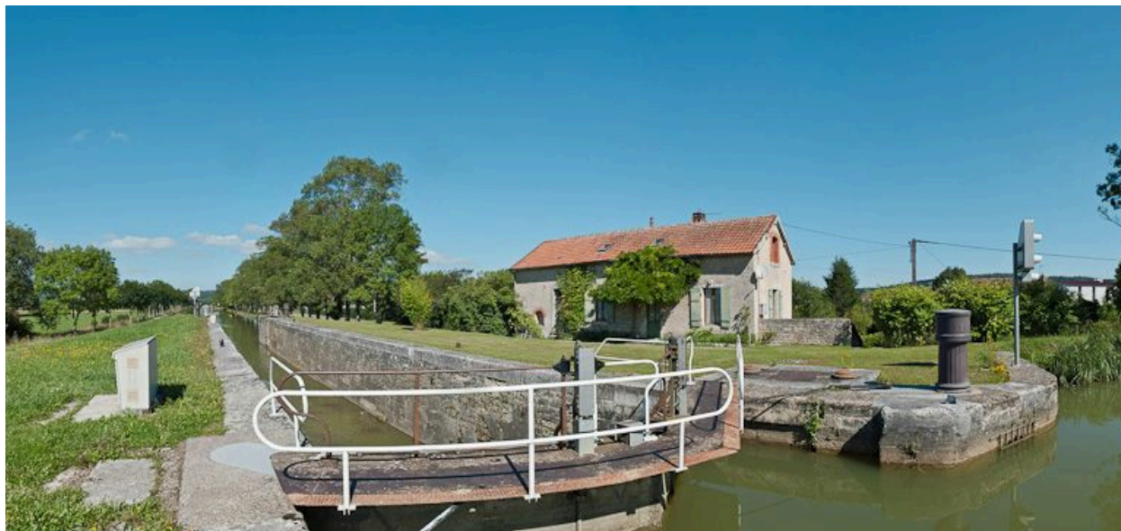
Vue d'ensemble du site d'écluse.
