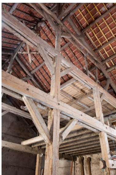
Grange : vue de la charpente. Phot. Jérôme Mongreville IVR43_20102500626NUC4A
