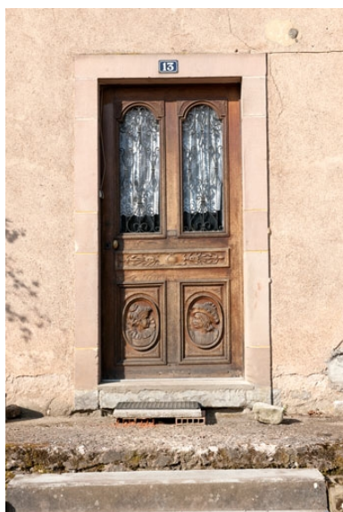
Logis (côté rue) : porte d'entrée.
