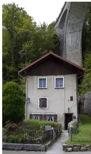
Elévation antérieure. Phot. Yves Sancey IVR43_20103900480NUC2A
