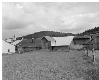
Fermes situées rue de la Fontaine : façades postérieures. Phot. Yves Sancey IVR43_19782500489X
