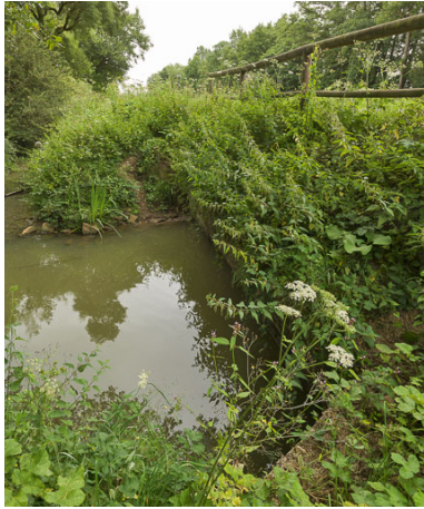
Vue de l'aqueduc.
