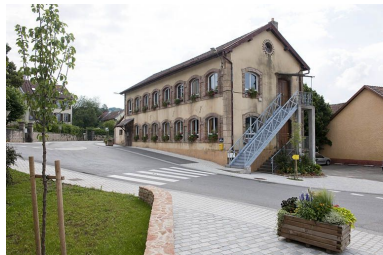
Vue rapprochée depuis l'ouest. Phot. Jérôme Mongreville IVR43_20122501108NUC4A
