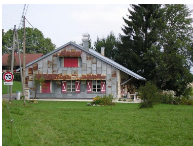
Vue de la façade sud-ouest.
