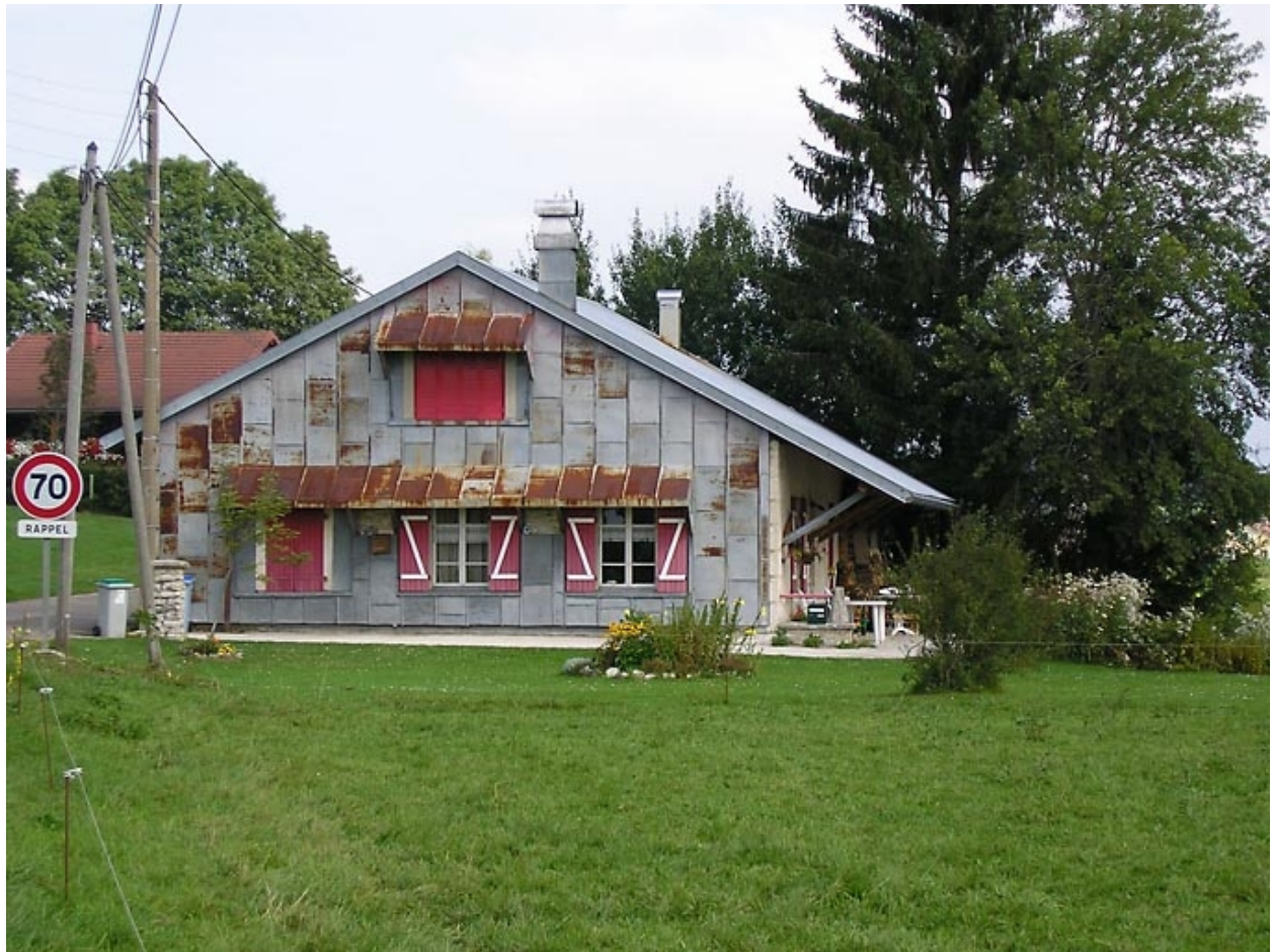
Vue de la façade sud-ouest.
