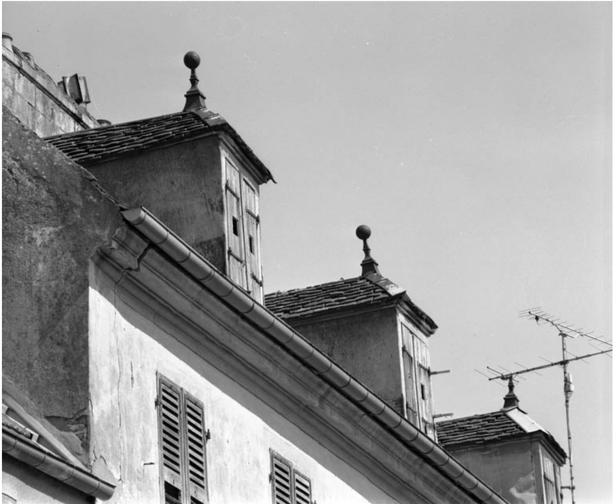
Façade antérieure : détail des lucarnes.
