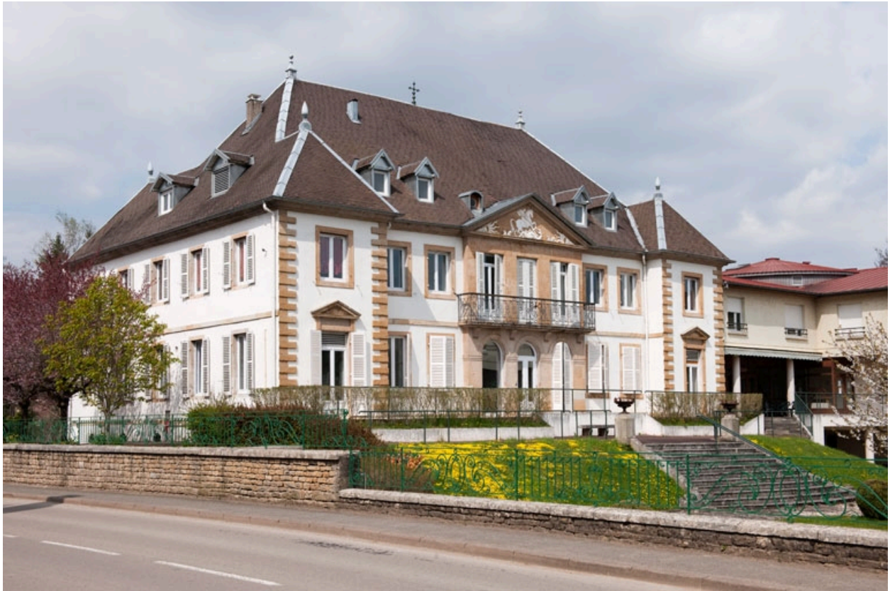
Façade antérieure et face latérale gauche depuis la rue du Vieux Moulin.
