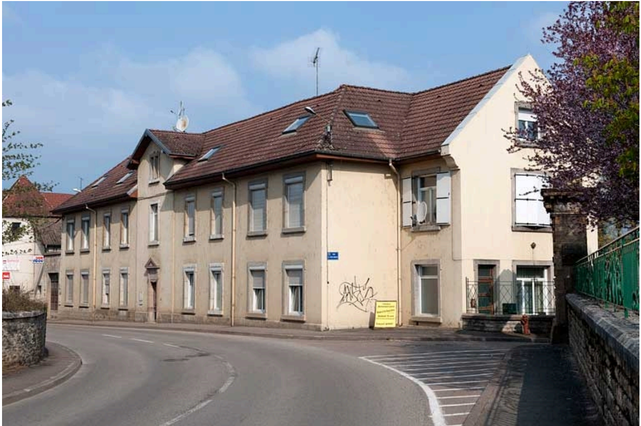
Vue générale de l'ancien pavillon d'isolement.
