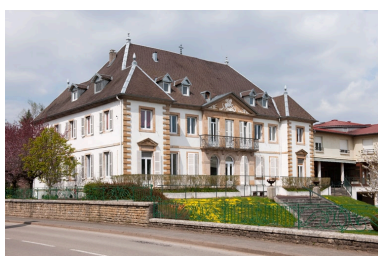
Façade antérieure et face latérale gauche depuis la rue du Vieux Moulin. Phot. Jérôme Mongreville IVR43_20102500369NUC4A
