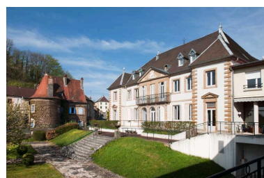
Vue d'ensemble de la maison du moulin et du château depuis le jardin. Phot. Jérôme Mongreville IVR43_20102500361NUC4A
