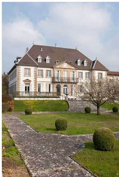
Façade antérieure depuis le jardin. Phot. Jérôme Mongreville IVR43_20102500368NUC4A
