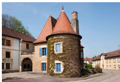
Vue d'ensemble de la porte du Vieux Moulin, de la maison du Vieux Moulin et de l'ancien pavillon d'isolement. Phot. Jérôme Mongreville IVR43_20102500356NUC4A
