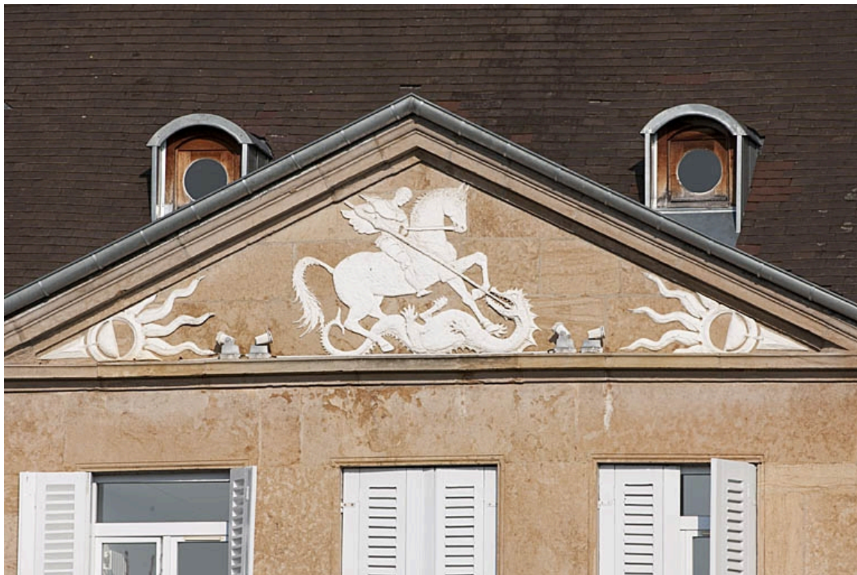
Façade antérieure, détail : le relief du fronton représentant saint Georges terrassant le dragon.
