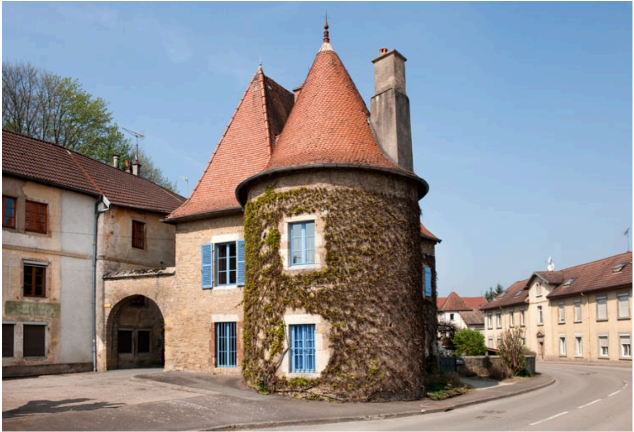
Vue d'ensemble de la porte du Vieux Moulin, de la maison du Vieux Moulin et de l'ancien pavillon d'isolement.
