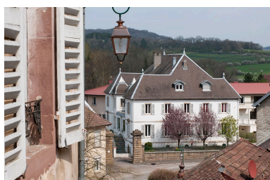
Vue rapprochée depuis la rue de la Petite Côte. Phot. Jérôme Mongreville IVR43_20102500372NUC4A
