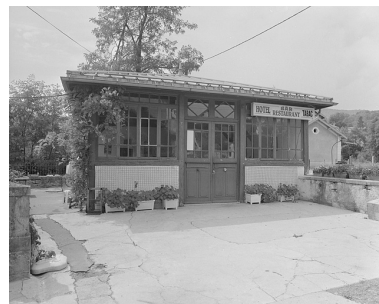
La guinguette : salle de bal, façade antérieure. Phot. Jérôme Mongreville IVR43_19963900970X
