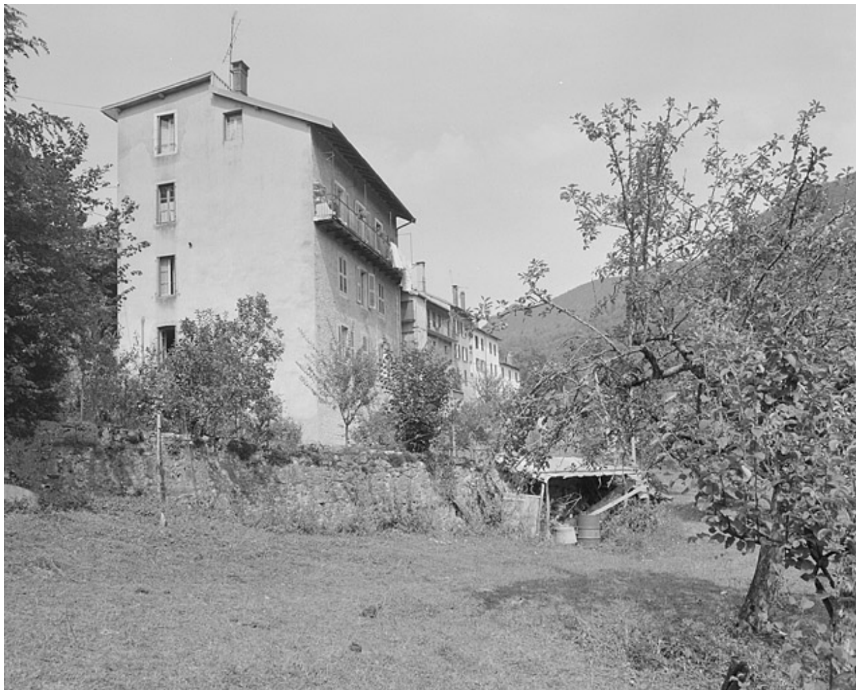
Face droite et façade postérieure.
