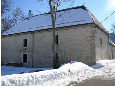
Façade latérale vue de trois quarts.
