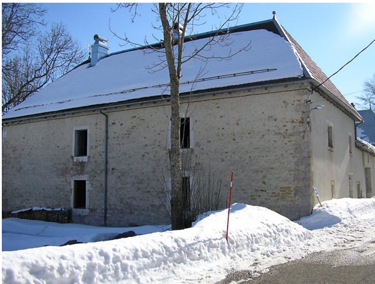
Façade latérale vue de trois quarts.
