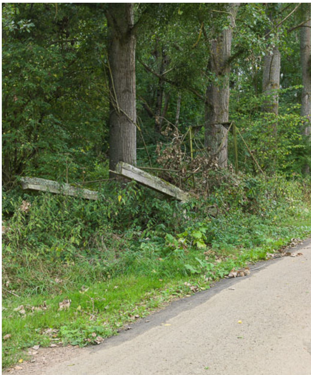
Ancienne passerelle abandonnée.
