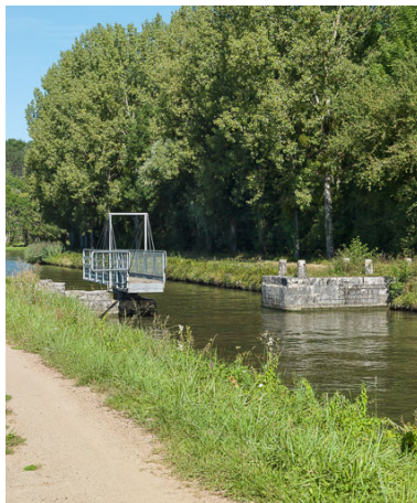
Vue d'ensemble de la passerelle. Phot. Pierre-Marie Barbe-Richaud IVR26_20175800395NUC2A
