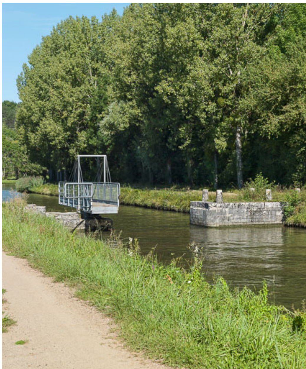
Vue d'ensemble de la passerelle.
