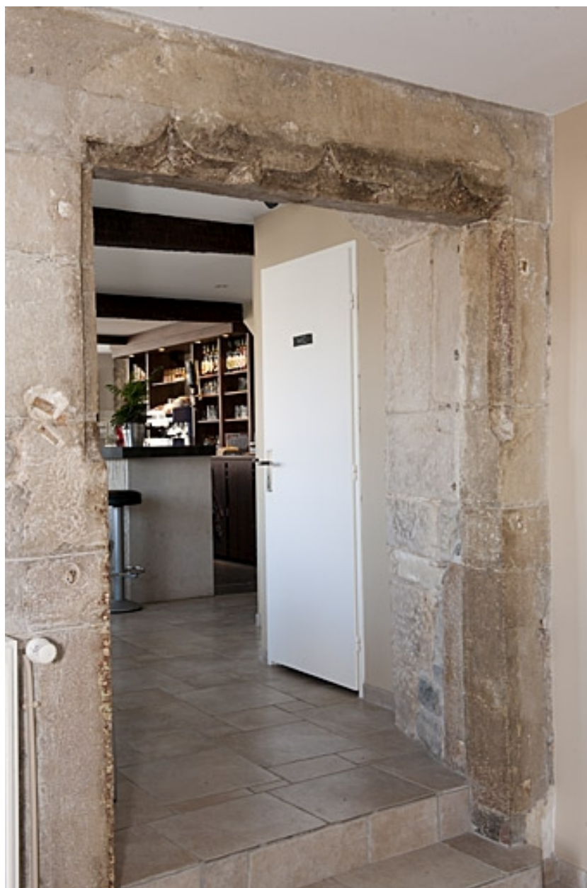
Ancienne baie d'une maison construite sur le mur d'enceinte, 1 place du Marché.
