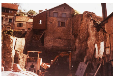
[Une partie du mur d'enceinte en cours de destruction vers 1983-1984, 29 Grande Rue]. Phot. Jérôme Mongreville, Autr. Gérard Grojean IVR43_20102501423NUC4A
