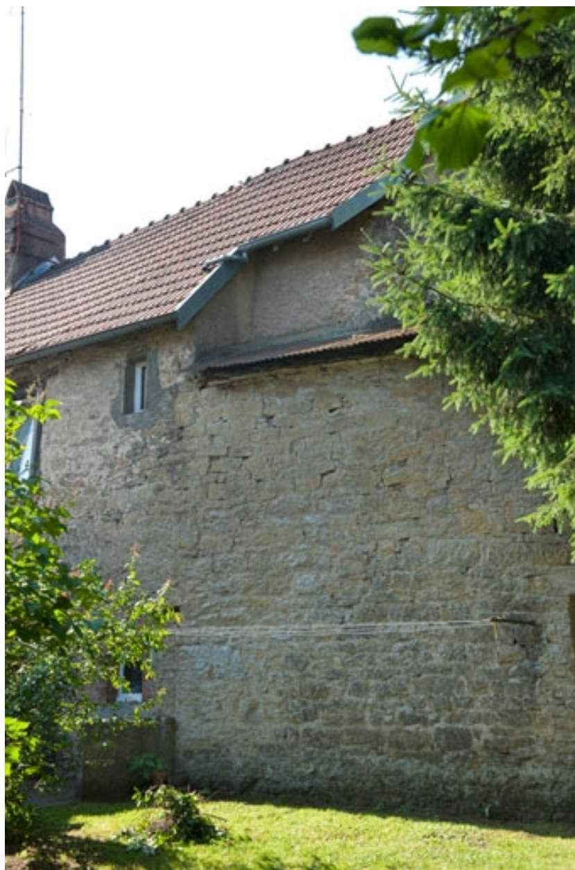
Construction élevée sur le mur d'enceinte, 7 rue du Vieux Moulin.
