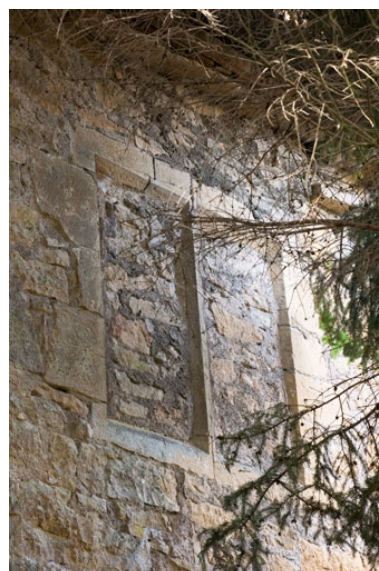
Exemple d'une baie à meneaux (16e siècle) aménagée dans le mur d'enceinte, 7 rue du Vieux Moulin. Phot. Jérôme Mongreville IVR43_20102500650NUC4A
