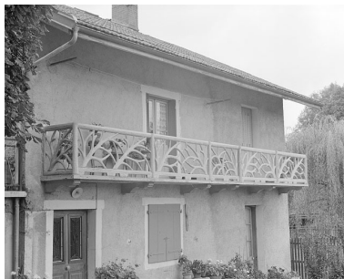
Garde-corps de balcon d'une ferme. Phot. Jérôme Mongreville IVR43_19963901018X
