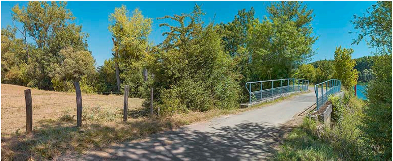
Vue d'ensemble, d'aval.
