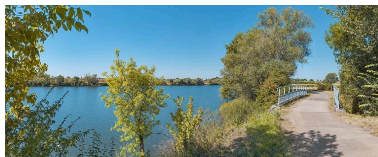
Le pont sur la Vandaine. Phot. Thierry Kuntz IVR26_20207100287NUC4A
