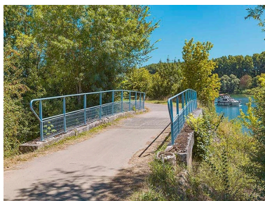
Vue d'ensemble du pont, d'aval. Phot. Thierry Kuntz IVR26_20207100290NUC4A
