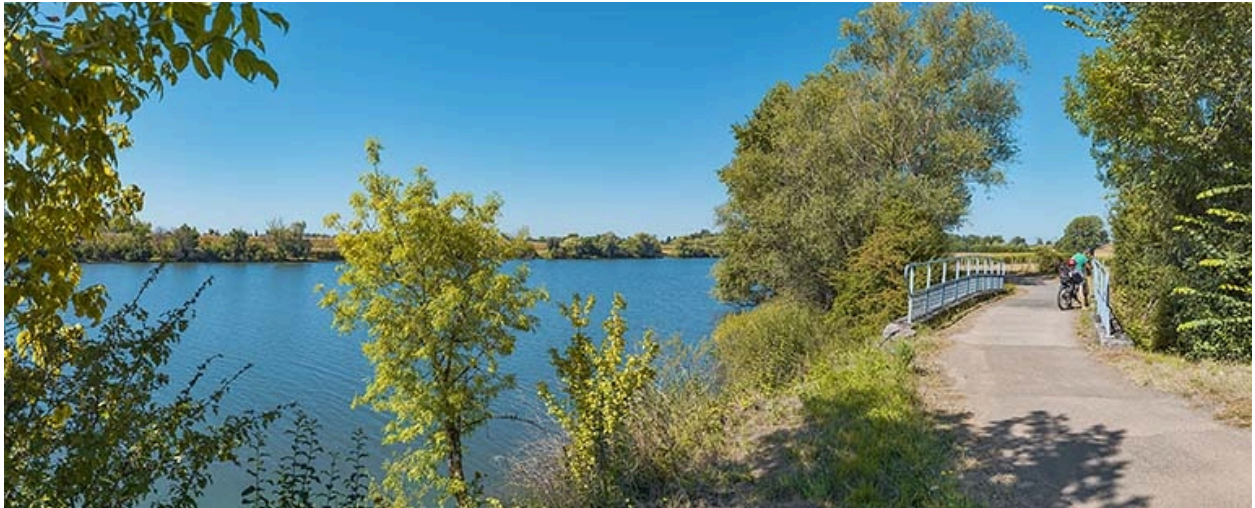
Le pont sur la Vandaine.
