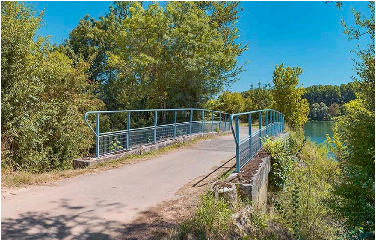
Vue d'ensemble, d'aval.
