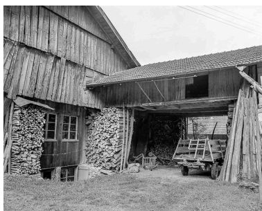
Détail : entrée de grange. Phot. Dominique Humbert IVR43_19762500632X
