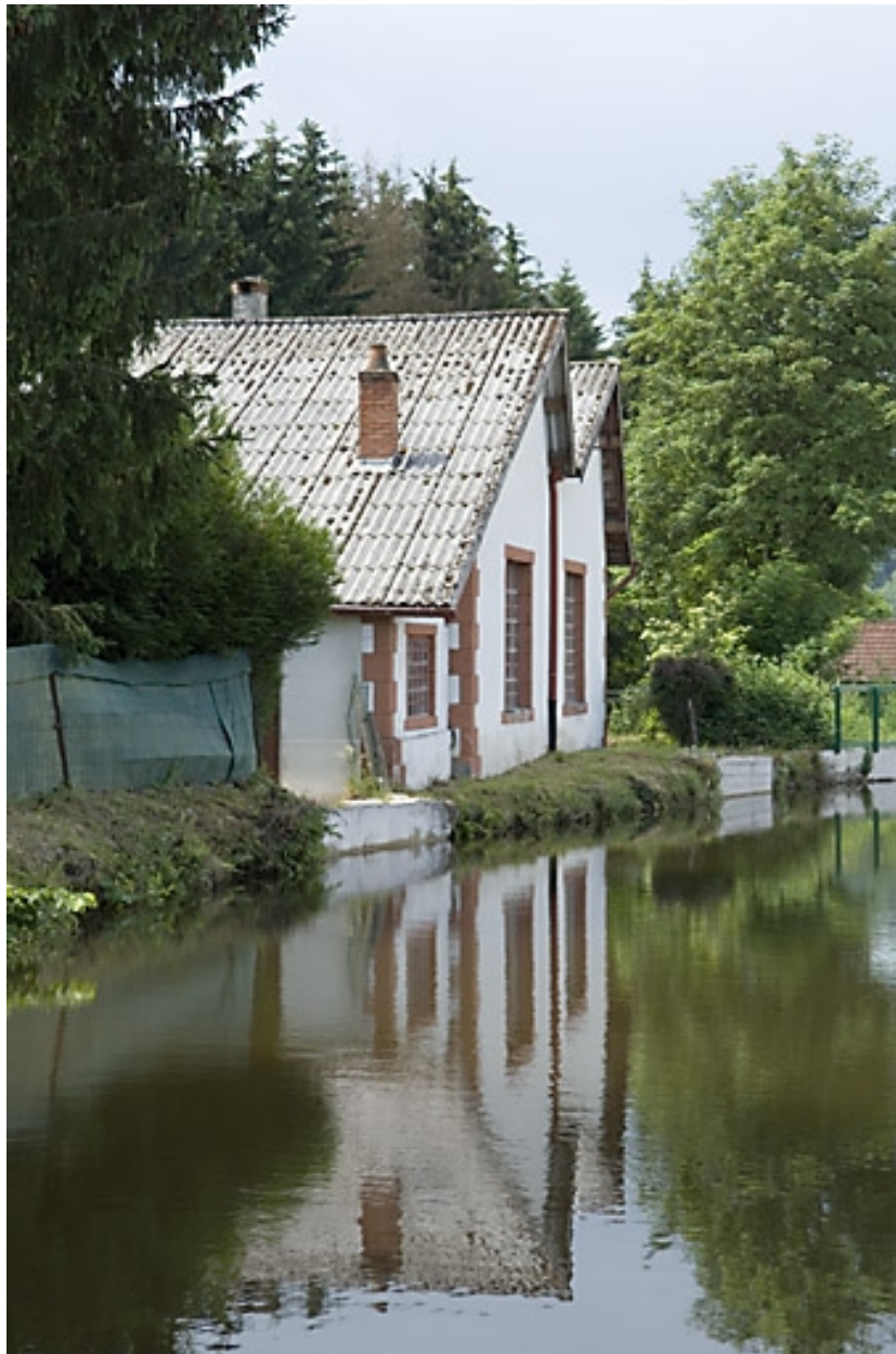
Atelier de réparation sur le bief d'amenée.
