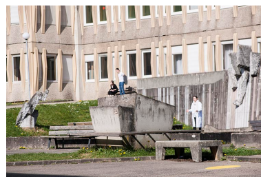
Détail. Phot. Jérôme Mongreville IVR43_20142500409NUC4A
