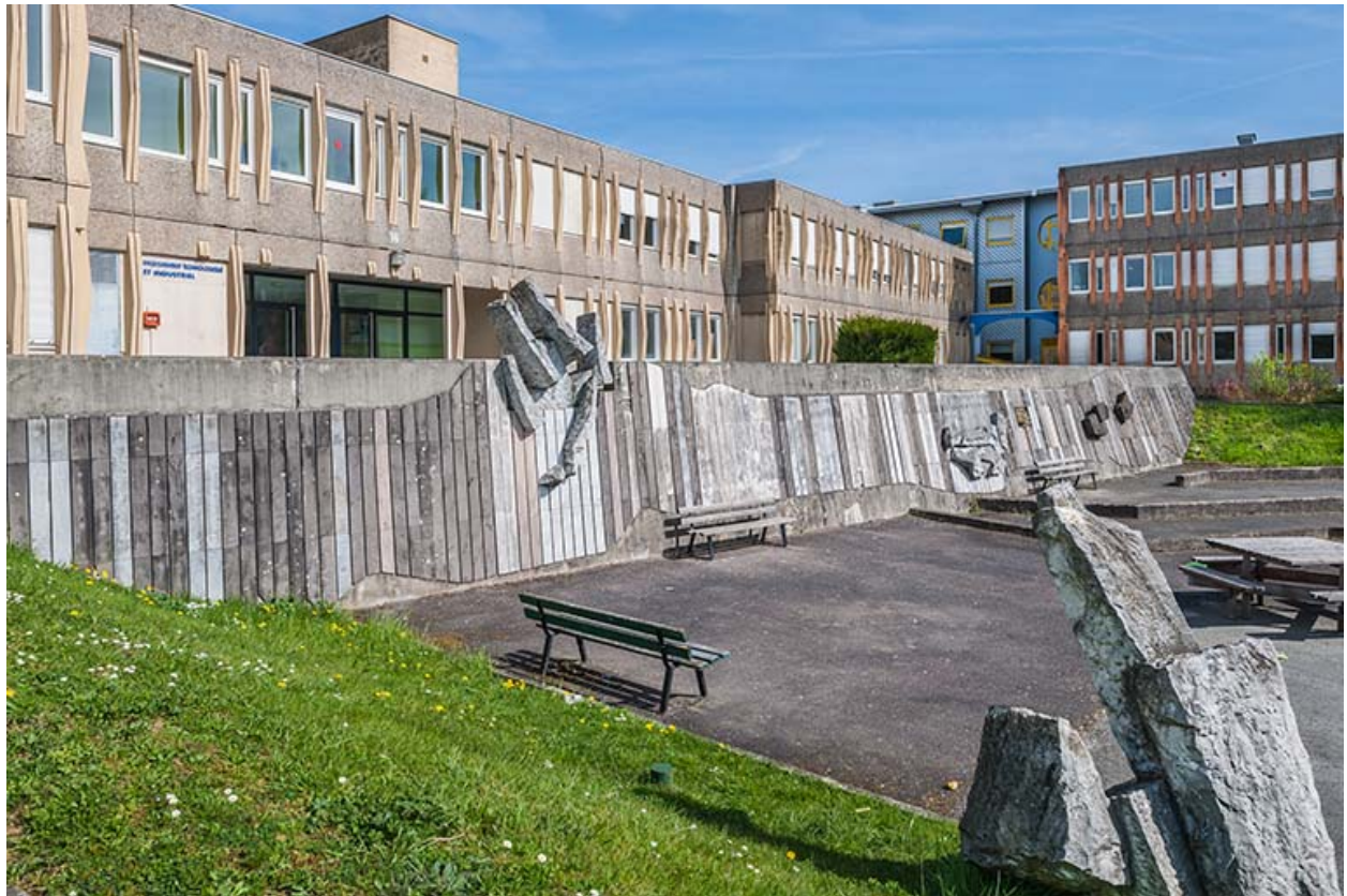
L'oeuvre dans son contexte, vue de l'ouest.
