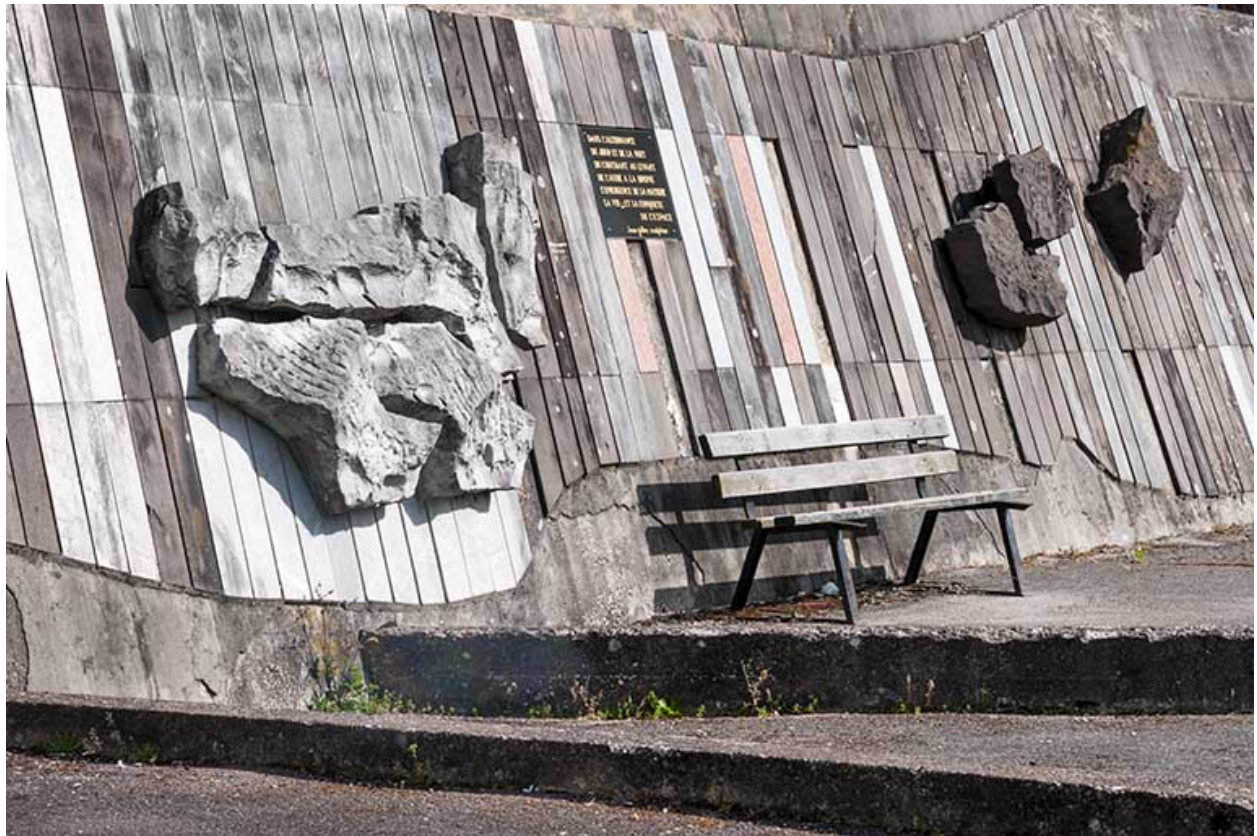
Vue de détail, depuis l'ouest.
