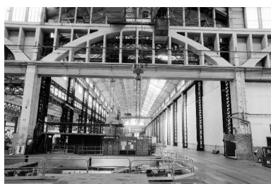
Les ateliers construits en 1912-1913 (travées orientales) vus depuis la halle de montage de 1919. Phot. Frédéric Pillet IVR26_20007100460Z
