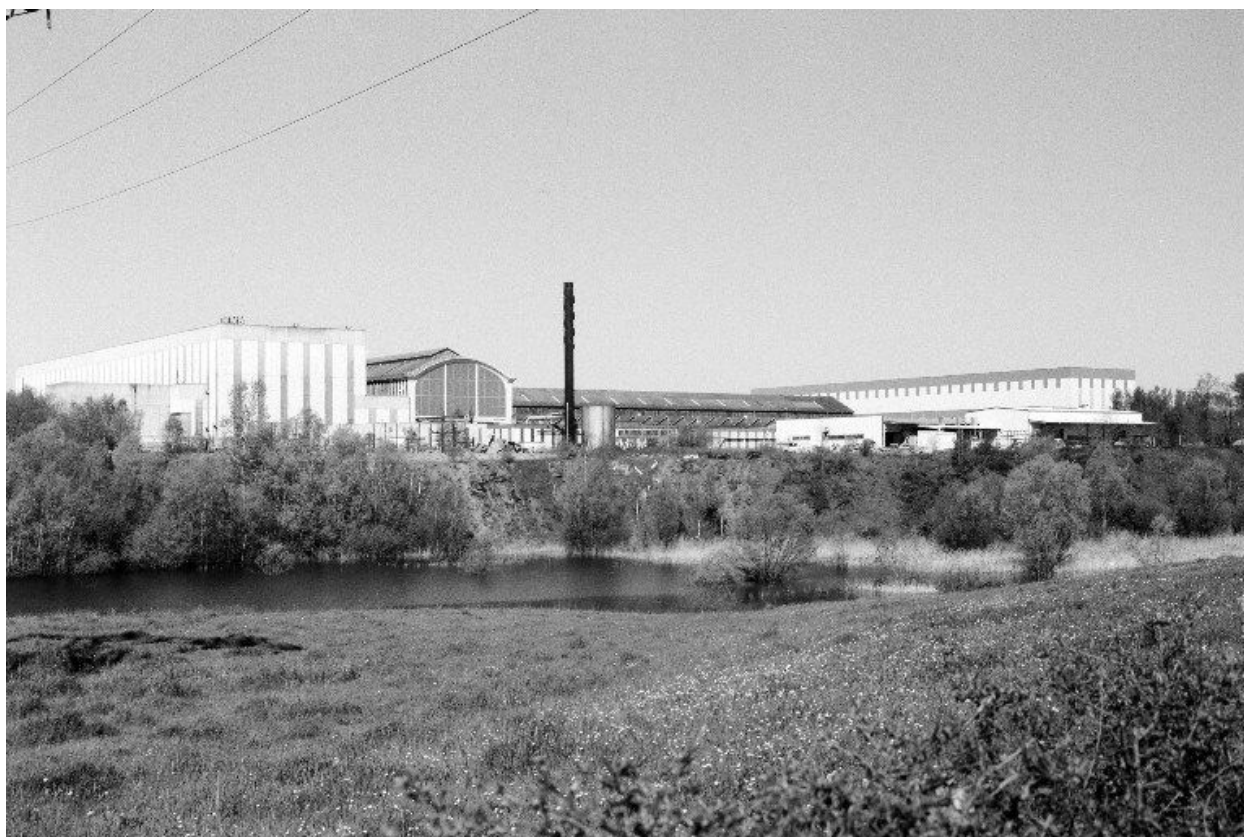
Les ateliers de construction mécanique CM1 vus du sud-est.
