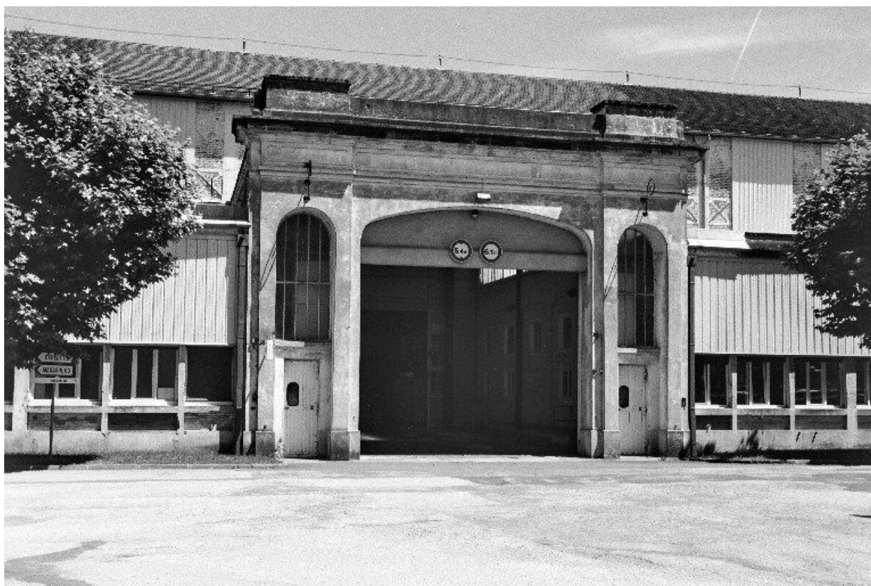
Porche de l'annexe ouest.
