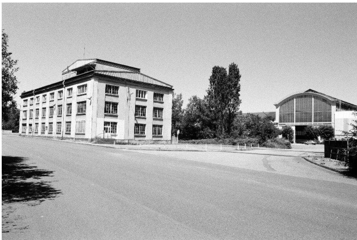
De gauche à droite, la sous-station électrique et la halle de montage.
