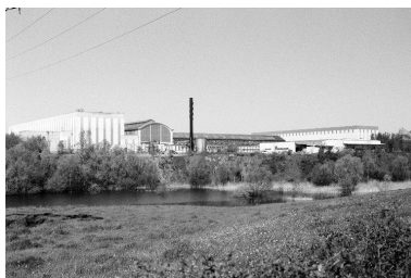
Les ateliers de construction mécanique CM1 vus du sud-est. Phot. Frédéric Pillet IVR26_20007100458Z
