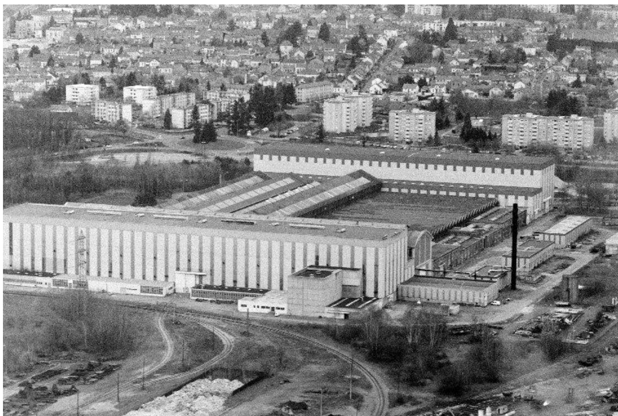
Vue aérienne des ateliers de construction mécanique CM 1 vus du sud.
