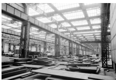
Les ateliers construits entre 1914 et 1917, couverts de sheds. Phot. Frédéric Pillet IVR26_20007100461Z
