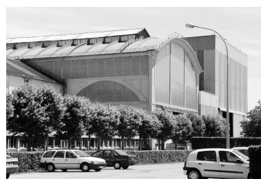
La halle de montage de 1919 et l'ATelier Lourd de 1973-1974, pignons ouest. Phot. Frédéric Pillet IVR26_20007100462Z
