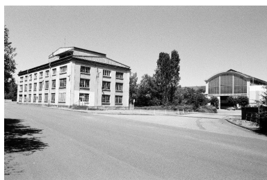
De gauche à droite, la sous-station électrique et la halle de montage. Phot. Frédéric Pillet IVR26_20007100466Z
