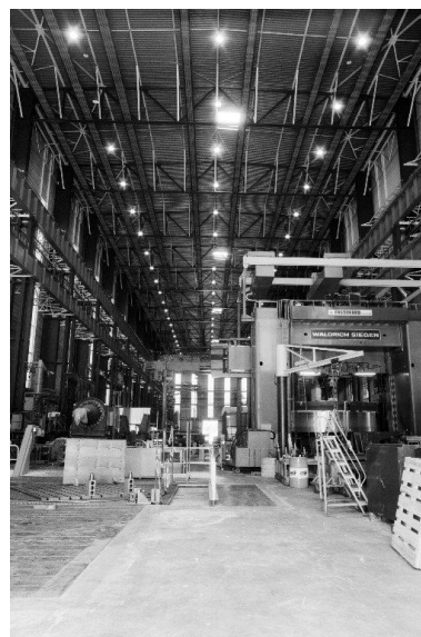
L'Atelier Nord de 1974-1975, vu de l'ouest. Phot. Frédéric Pillet IVR26_20007100468Z
