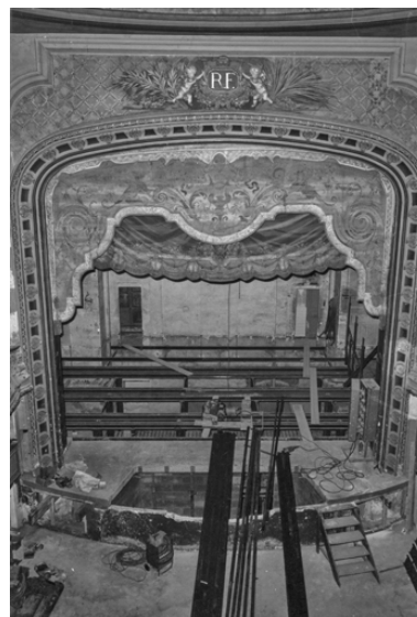
[Vue plongeante sur la cage de scène, avec le 1er dessous en construction]. S.d. [1980]. Autr. auteur inconnu IVR26_20238900291NUC4A
