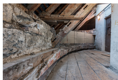
Comble de l'ancien théâtre : charpente et vestige de la coupole. Phot. Pierre-Marie Barbe-Richaud IVR26_20238900216NUC4A
