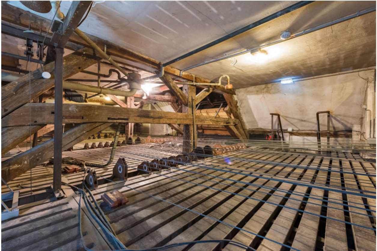
Comble de l'ancien théâtre : le gril.
