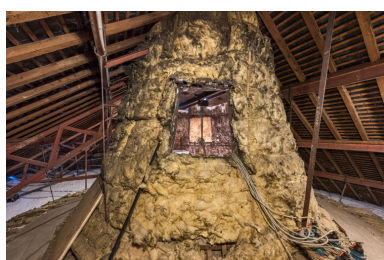
Comble de la salle : cheminée d'aération. Phot. Pierre-Marie Barbe-Richaud IVR26_20238900211NUC4A
