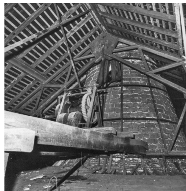
[Cheminée d'aération de la salle, avec le treuil du lustre]. S.d. [1980 ou 1981]. Autr. auteur inconnu IVR26_20238900293NUC2A
