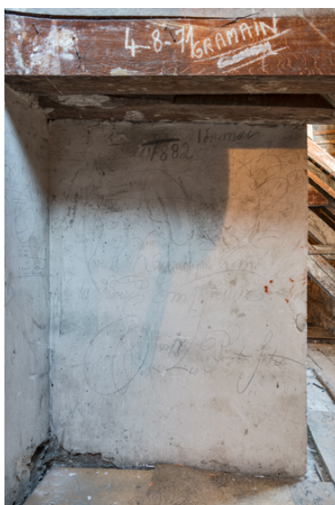
Comble de l'ancien théâtre : graffitis (dont "Vive la République, à mort les Rois et Empereurs"). Phot. Pierre-Marie Barbe-Richaud IVR26_20238900218NUC4A
