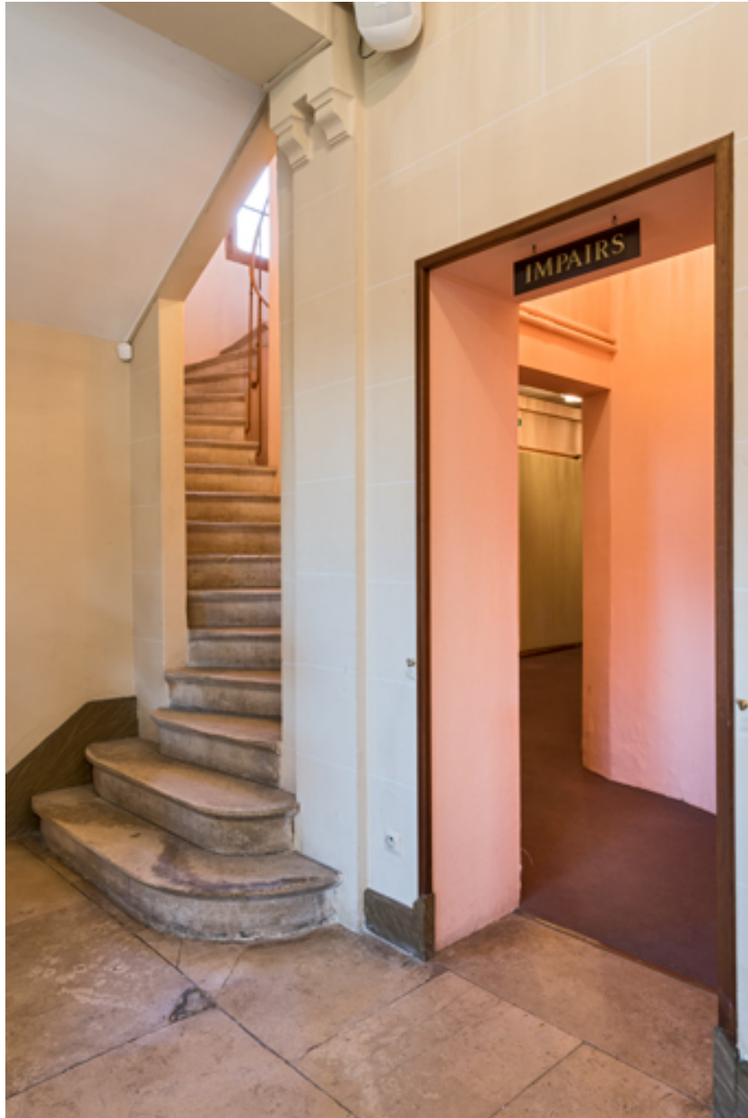
Vestibule : escalier côté jardin desservant les balcons.
