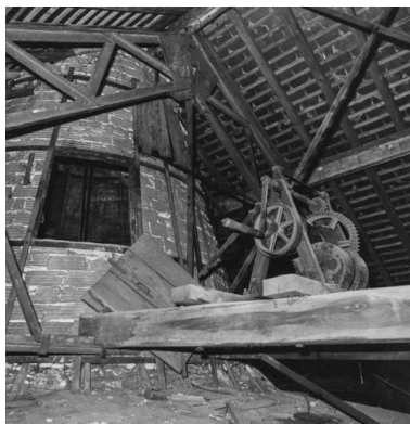
[Cheminée d'aération de la salle, avec le treuil du lustre]. S.d. [1980 ou 1981]. Autr. auteur inconnu IVR26_20238900294NUC2A
