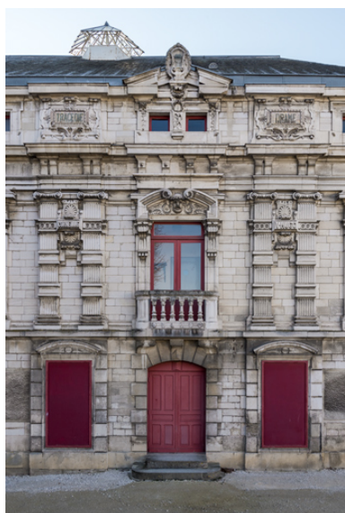
Façade latérale gauche : travées centrales.
