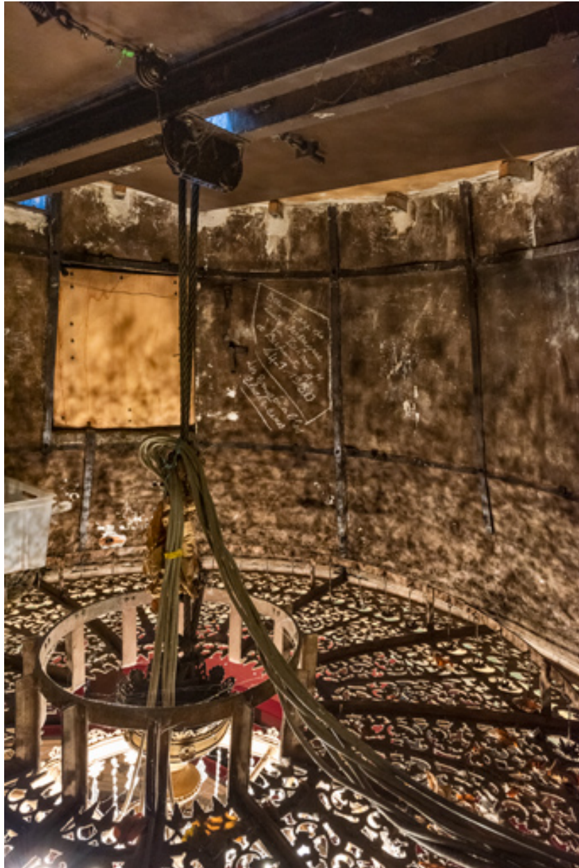
Comble de la salle, cheminée d'aération : intérieur.
