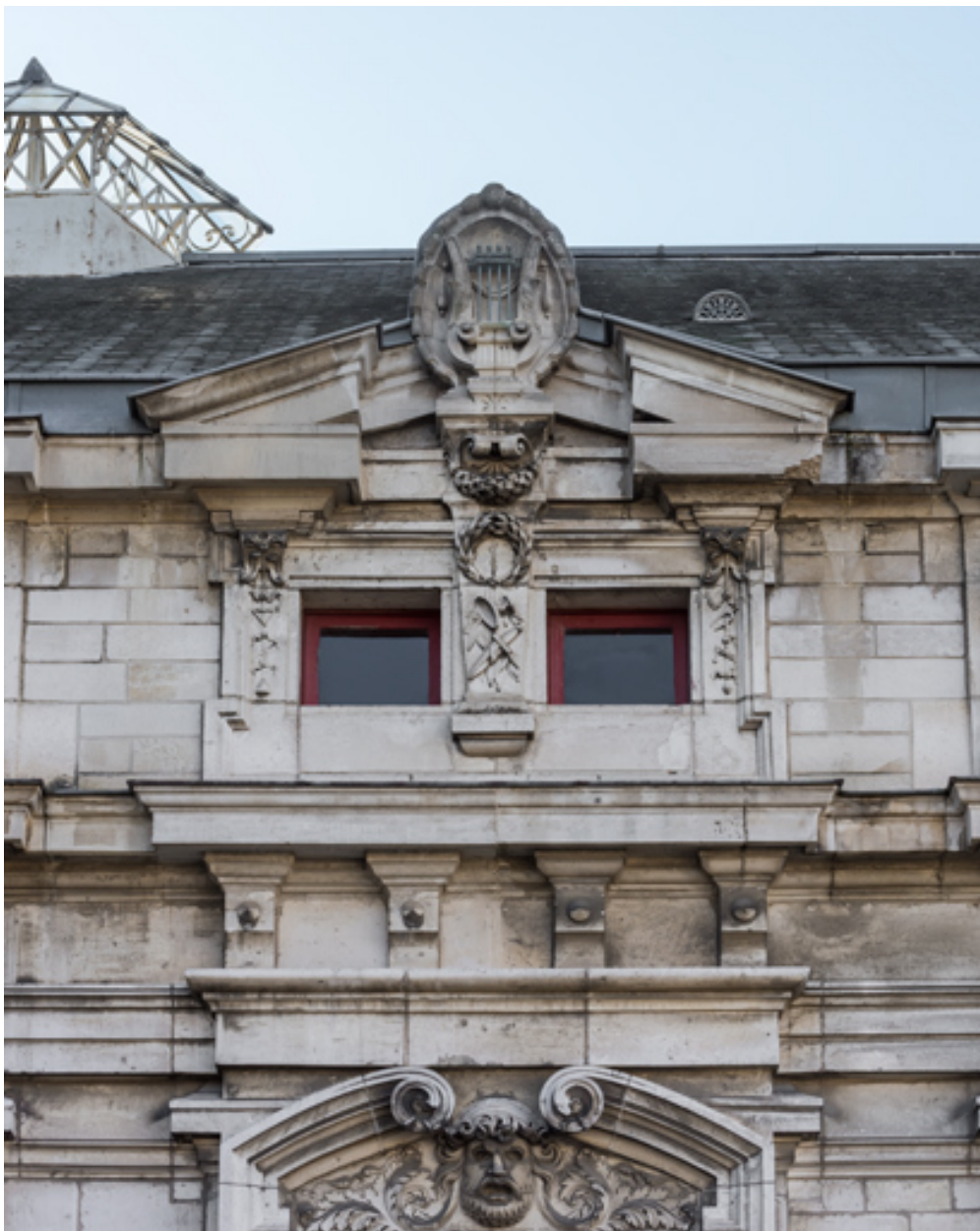
Façade latérale gauche : décor en partie haute de la travée centrale.
