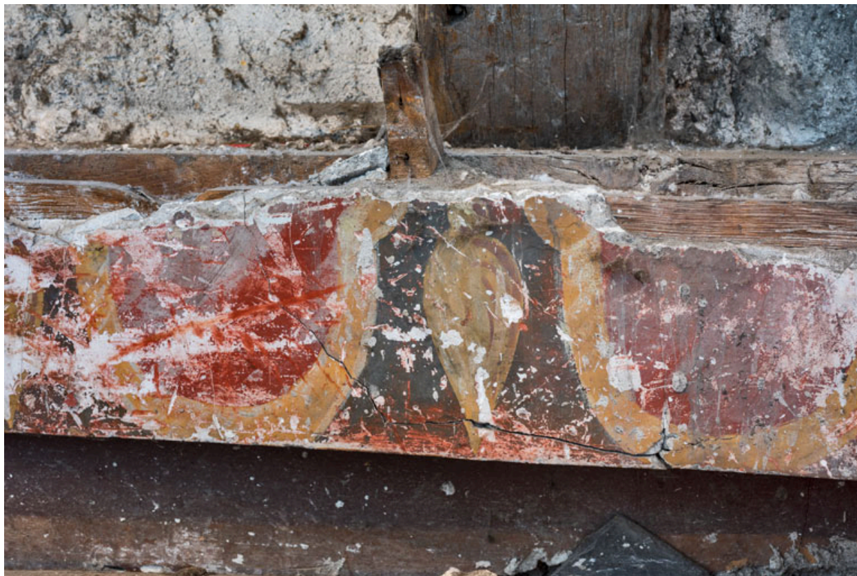
Comble de l'ancien théâtre : vestige du décor de la coupole.
