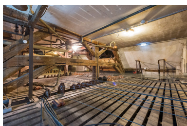
Comble de l'ancien théâtre : le gril. Phot. Pierre-Marie Barbe-Richaud IVR26_20238900215NUC4A
