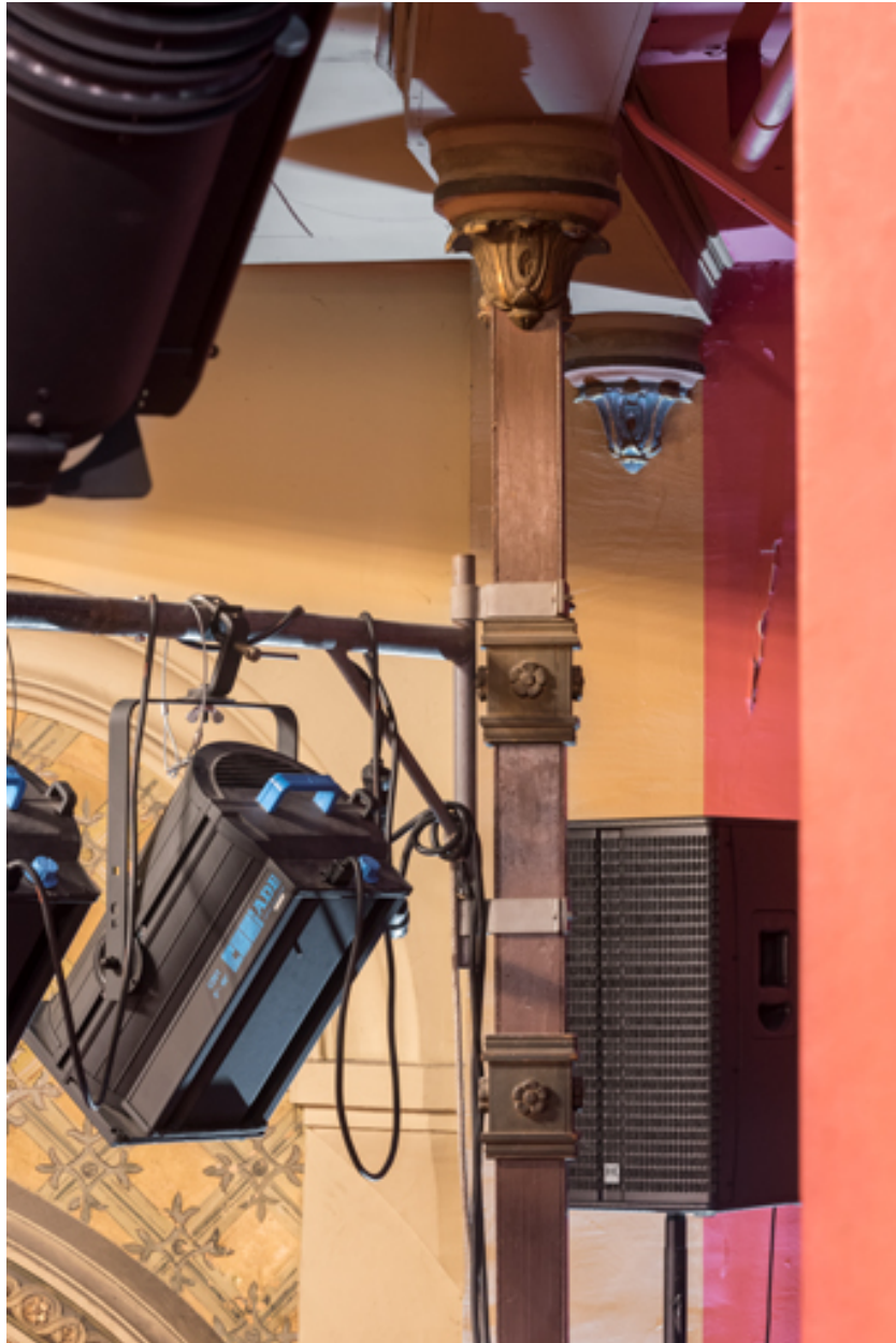
Salle, 2e balcon : poteau à l'extrémité côté cour.
