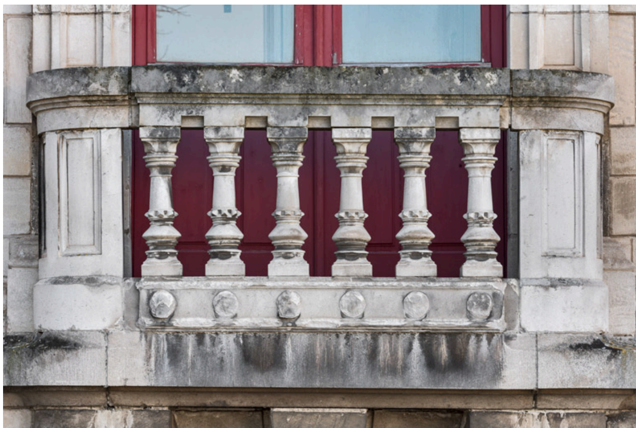
Façade latérale gauche : garde-corps du balcon.
