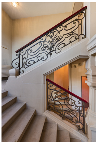
Vestibule : rampes de l'escalier principal. Phot. Pierre-Marie Barbe-Richaud IVR26_20238900176NUC4A
