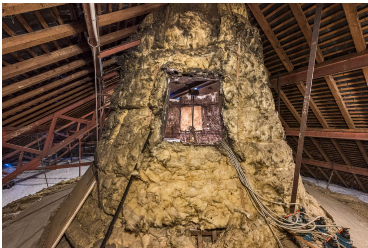
Comble de la salle : cheminée d'aération.
