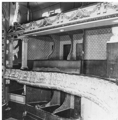
[Loges et loges d'avant-scène côté cour]. S.d. [1980]. Autr. auteur inconnu IVR26_20238900292NUC2A
