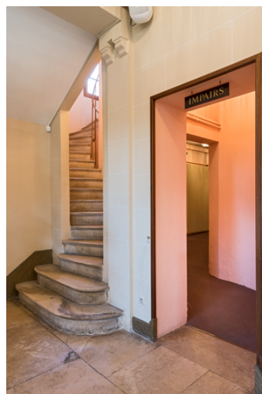
Vestibule : escalier côté jardin desservant les balcons. Phot. Pierre-Marie Barbe-Richaud IVR26_20238900175NUC4A
