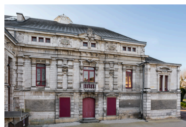
Façade latérale gauche : salle et vestibule. Phot. Pierre-Marie Barbe-Richaud IVR26_20238900142NUC4A
