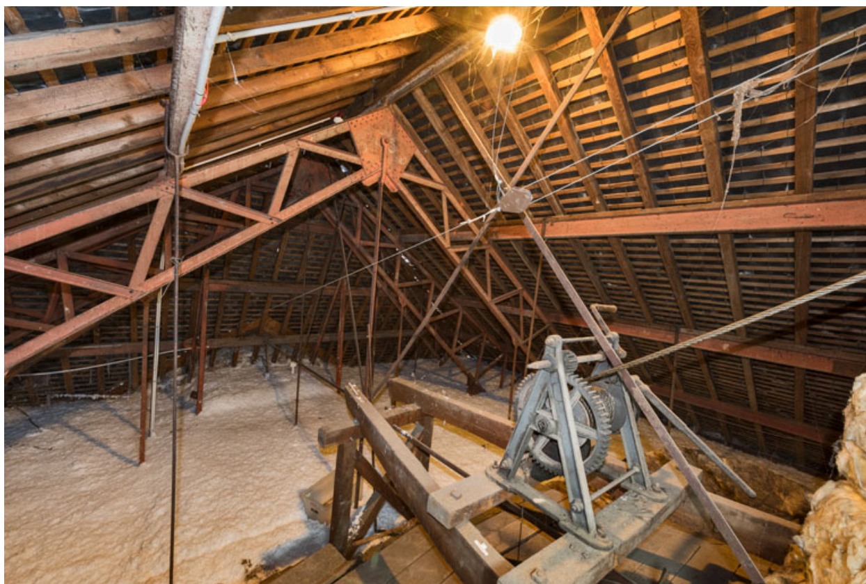
Comble de la salle : charpente métallique et treuil du lustre.
