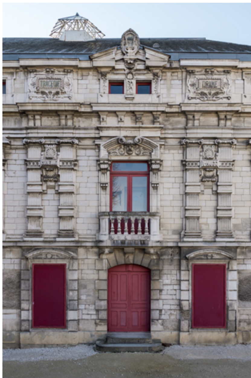
Façade latérale gauche : travées centrales.
