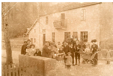
[Vue générale de l'hôtel de voyageurs], 1913. Phot. Jérôme Mongreville IVR43_20102501518NUC4A
