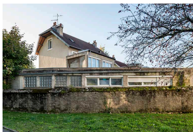
Atelier de fabrication depuis le nord. Phot. Jérôme Mongreville IVR43_20172501180NUC4A
