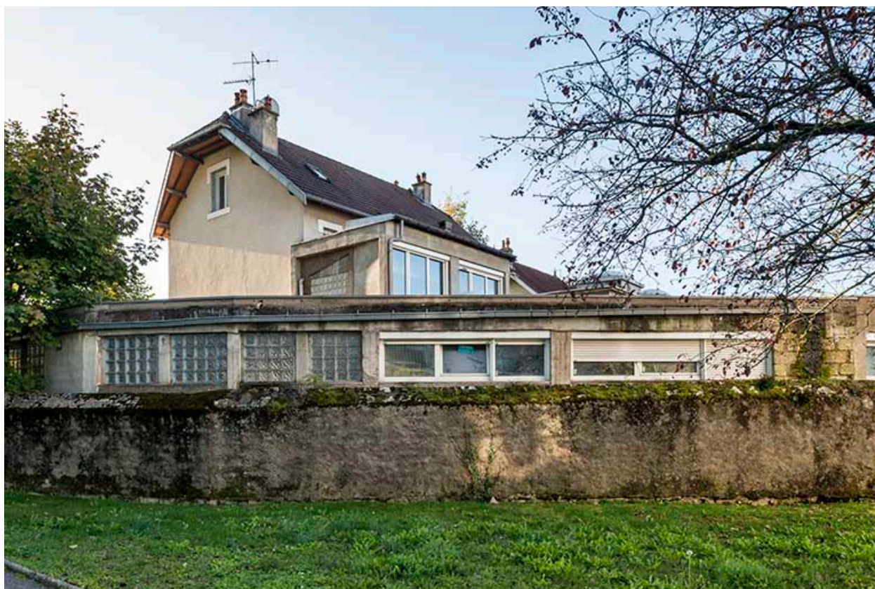
Atelier de fabrication depuis le nord.
