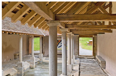
Vue de l'intérieur du lavoir. Phot. Pierre-Marie Barbe-Richaud IVR26_20105800050NUC2A
