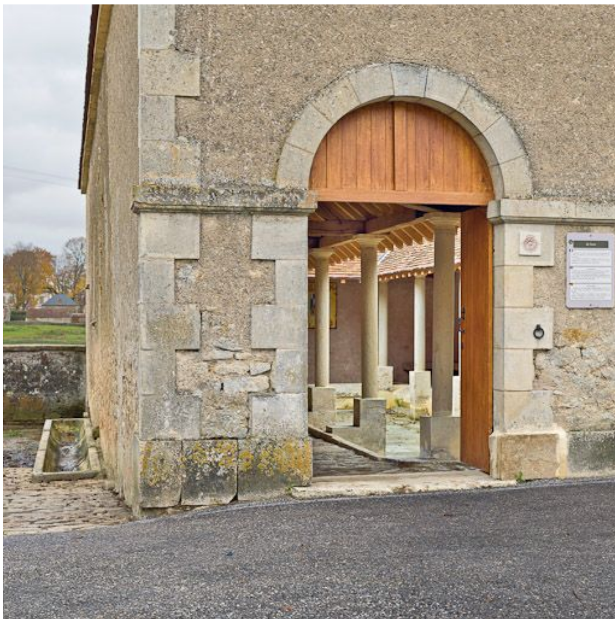
Vue rapprochée de l'une des deux ouvertures donnant accès au lavoir. A l'extérieur, à gauche, auge en pierre.
