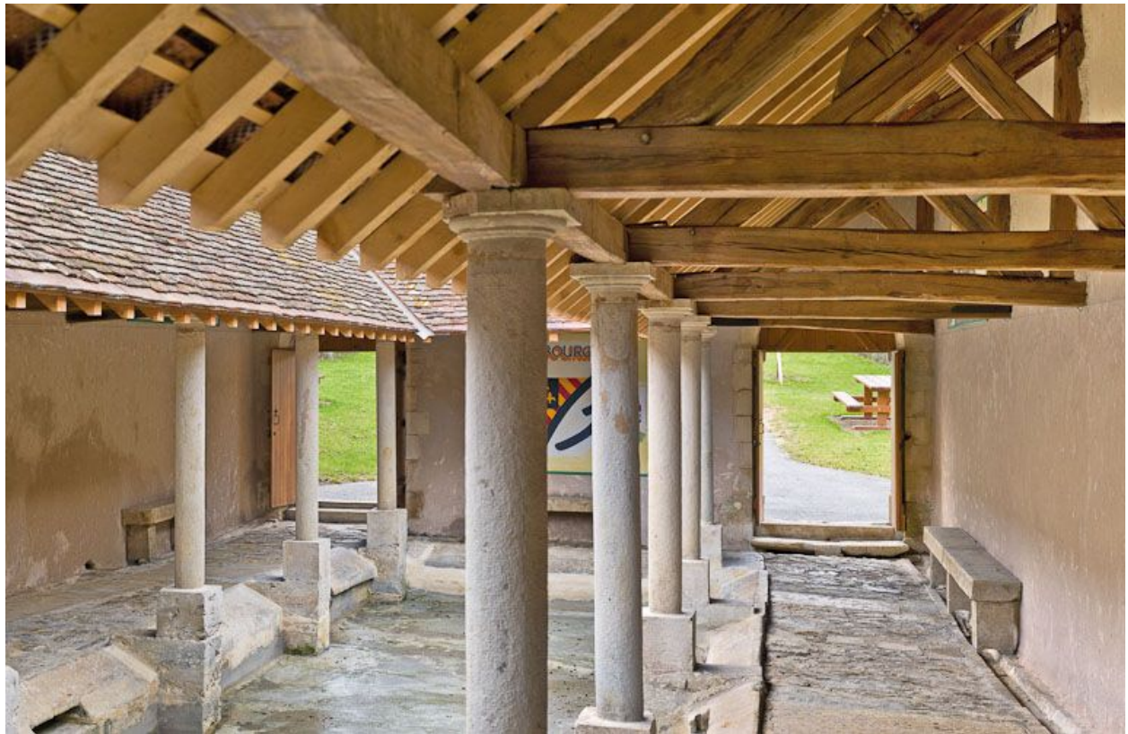
Vue de l'intérieur du lavoir.
