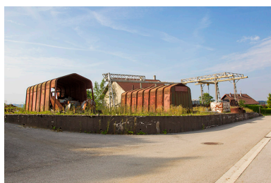
Site rue du Contremont : vue d'ensemble depuis le nord. Au premier plan, les bâtiments métalliques à parois inclinées Fillod. Phot. Yves Sancey IVR43_20132501436NUC2A
