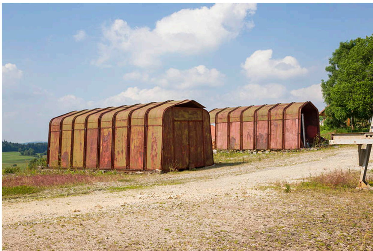
Site rue du Contremont : bâtiments métalliques à parois inclinées Fillod.
