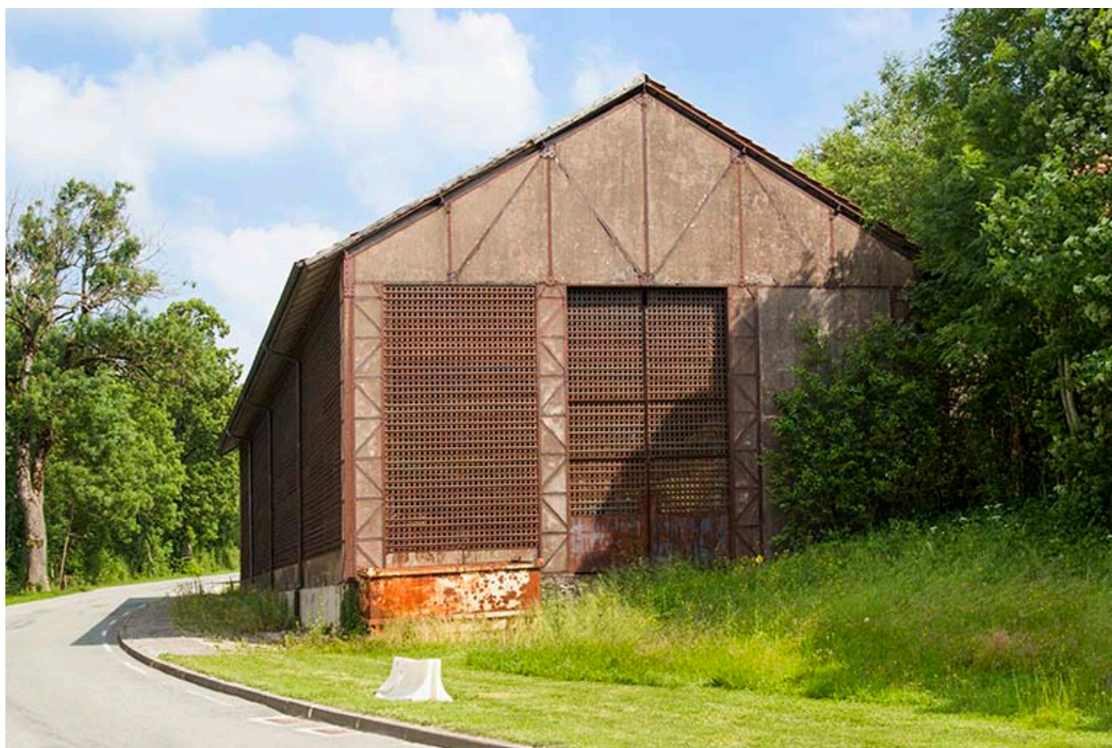
Site rue du Jura : entrepôt industriel, vu depuis l'atelier de fabrication.
