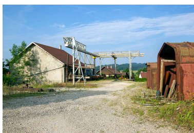
Site rue du Contremont : atelier de fabrication et portique, depuis le nord-est. Phot. Yves Sancey IVR43_20132501437NUC2A
