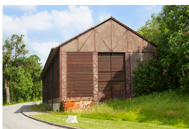
Site rue du Jura : entrepôt industriel, vu depuis l'atelier de fabrication. Phot. Yves Sancey IVR43_20132501483NUC2A
