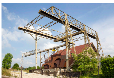
Site rue du Contremont : portique de manutention. Phot. Yves Sancey IVR43_20132501438NUC2A
