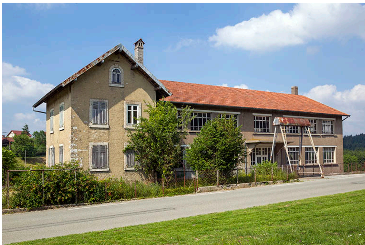
Site rue du Jura : logement, atelier de fabrication et portique (façade antérieure de trois quarts gauche).
