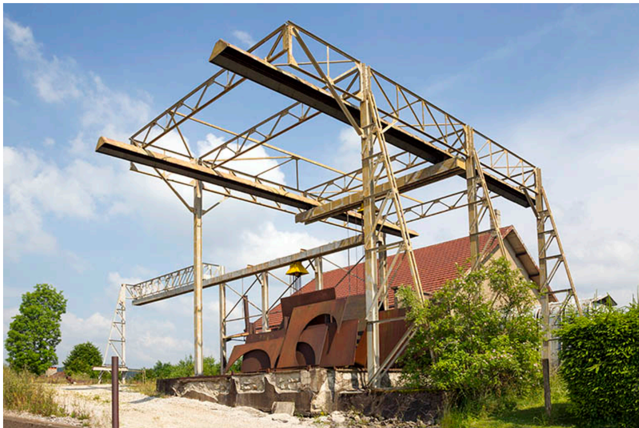
Site rue du Contremont : portique de manutention.
