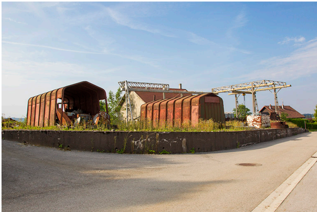
Site rue du Contremont : vue d'ensemble depuis le nord. Au premier plan, les bâtiments métalliques à parois inclinées Fillod.
