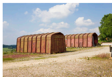
Site rue du Contremont : bâtiments métalliques à parois inclinées Fillod. Phot. Yves Sancey IVR43_20132501441NUC2A
