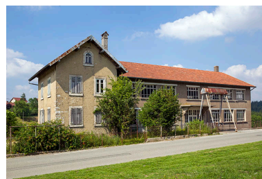
Site rue du Jura : logement, atelier de fabrication et portique (façade antérieure de trois quarts gauche). Phot. Yves Sancey IVR43_20132501482NUC2A
