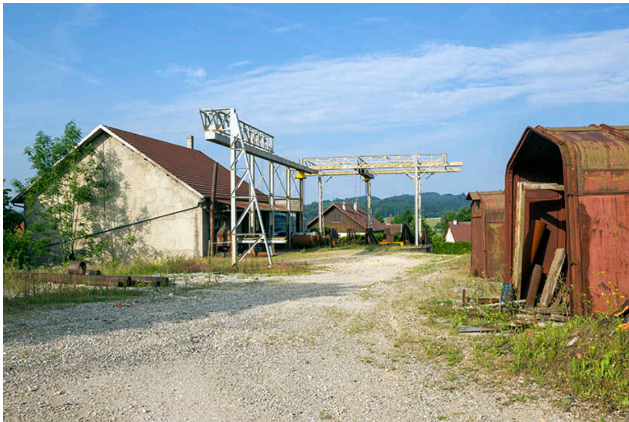
Site rue du Contremont : atelier de fabrication et portique, depuis le nord-est.
