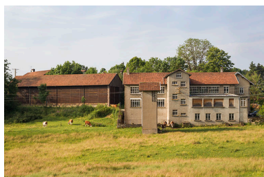
Site rue du Jura : vue d'ensemble depuis le nord. Phot. Yves Sancey IVR43_20132501487NUC2A
