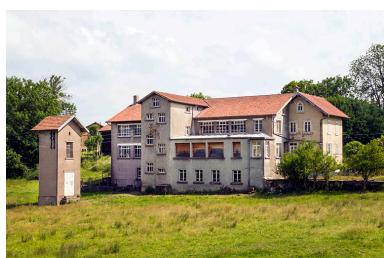
Site rue du Jura : atelier de fabrication et logement (façade postérieure). Phot. Yves Sancey IVR43_20132502967NUC2A
