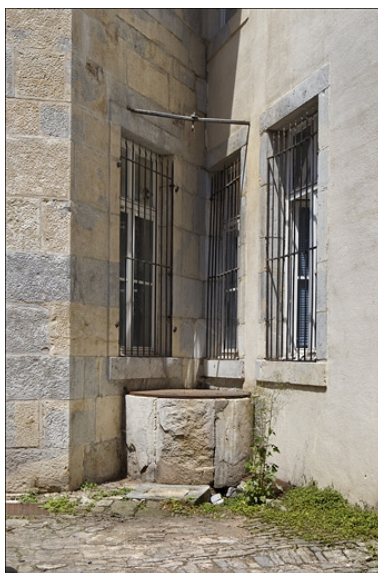
Deuxième cour : détail du puits. Phot. Yves Sancey IVR43_20102501250NUC2A
