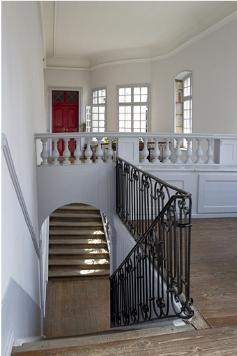
Détail de l'escalier secondaire depuis le palier.
