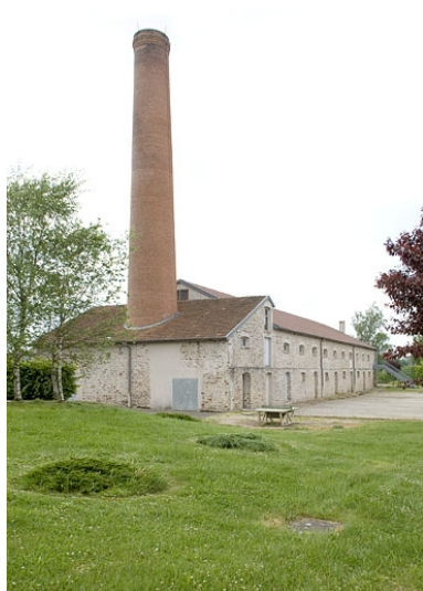
Vue de trois quarts depuis le nord-est.
