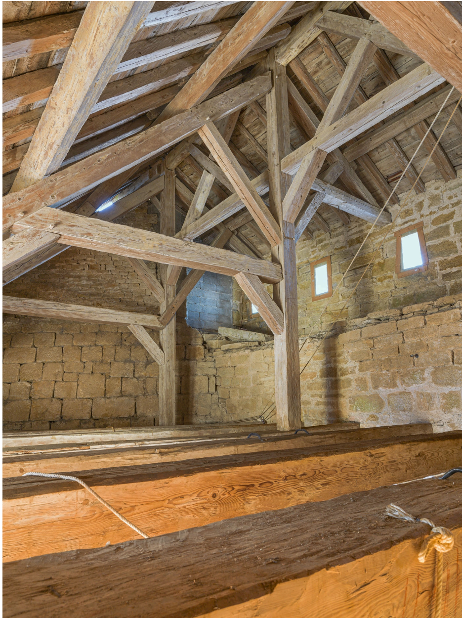
2e étage : détail de la charpente.
