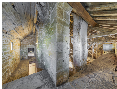
2e étage : le chemin de ronde. Phot. Thierry Kuntz IVR43_20213900387NUC4A
