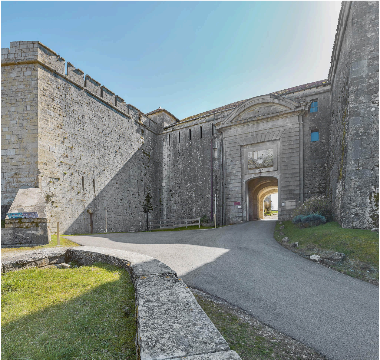
Accès actuel au fort après la suppression du pont.
