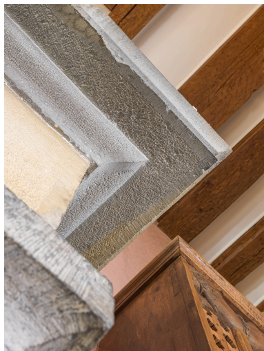
1er étage, logement destiné aux officiers : cheminée, détail du manteau. Phot. Thierry Kuntz IVR43_20213900360NUC4A
