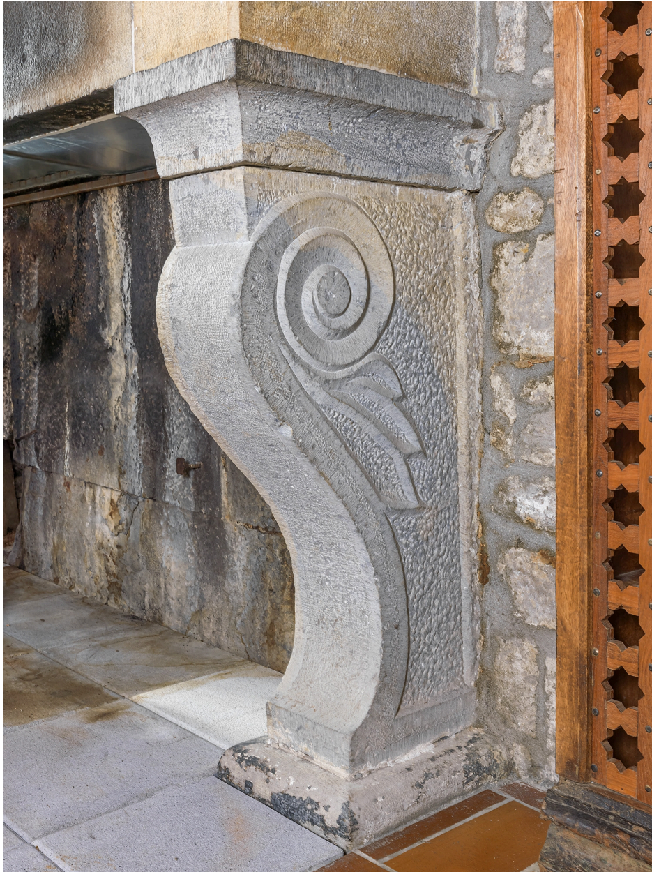
1er étage, logement destiné aux officiers : cheminée, détail du piedroit.
