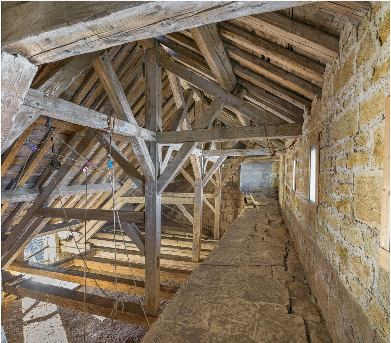
2e étage : charpente du bâtiment.
