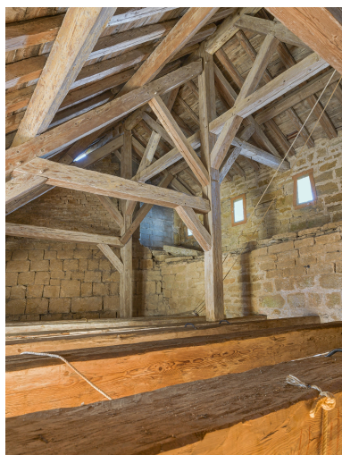
2e étage : détail de la charpente.
