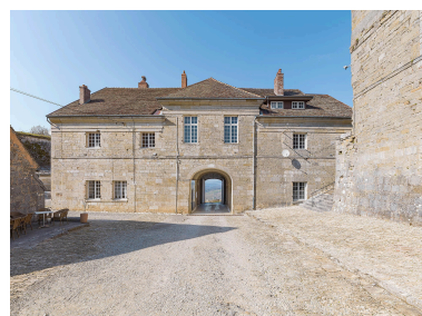
Façade postérieure du bâtiment. Phot. Thierry Kuntz IVR43_20223900541NUC4A
