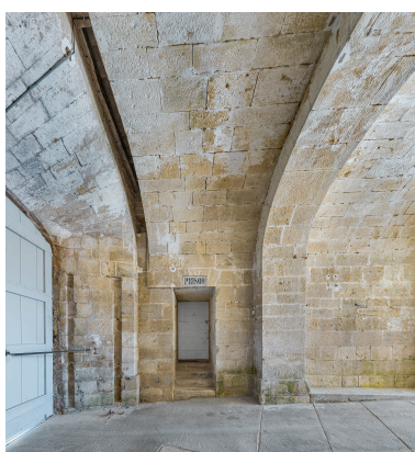
Le passage voûté : porte de l'ancienne prison. Phot. Thierry Kuntz IVR43_20213900363NUC4A
