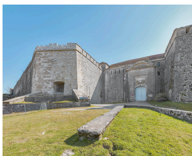
La porte d'entrée et les remparts l'encadrant. Phot. Thierry Kuntz IVR43_20223900532NUC4A
