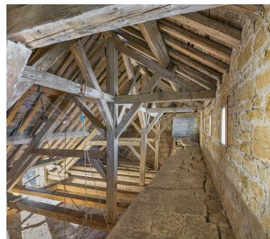
2e étage : charpente du bâtiment. Phot. Thierry Kuntz IVR43_20213900388NUC4A
