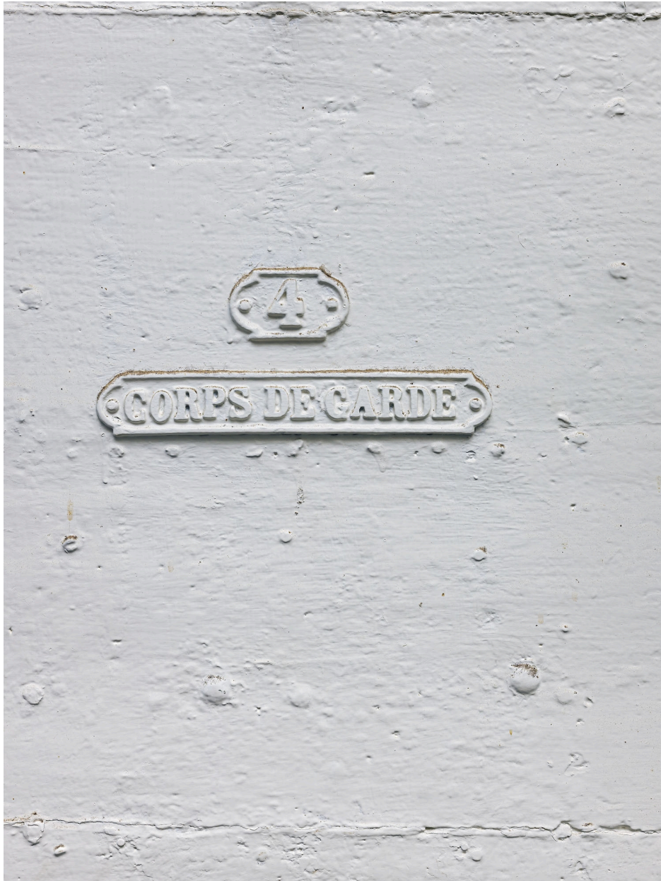
Le passage voûté : porte d'entrée du corps de garde (détail de l'inscription).
