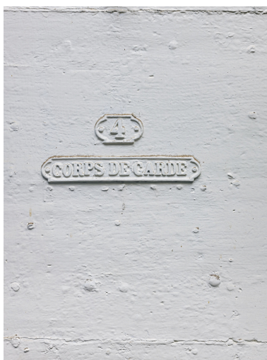
Le passage voûté : porte d'entrée du corps de garde (détail de l'inscription). Phot. Thierry Kuntz IVR43_20213900369NUC4A
