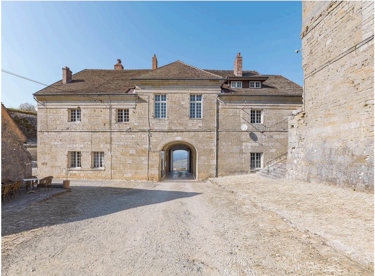
Façade postérieure du bâtiment.
