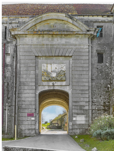
La porte d'entrée : vue d'ensemble. Phot. Thierry Kuntz IVR43_20223900535NUC4A
