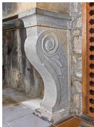
1er étage, logement destiné aux officiers : cheminée, détail du piedroit. Phot. Thierry Kuntz IVR43_20213900359NUC4A
