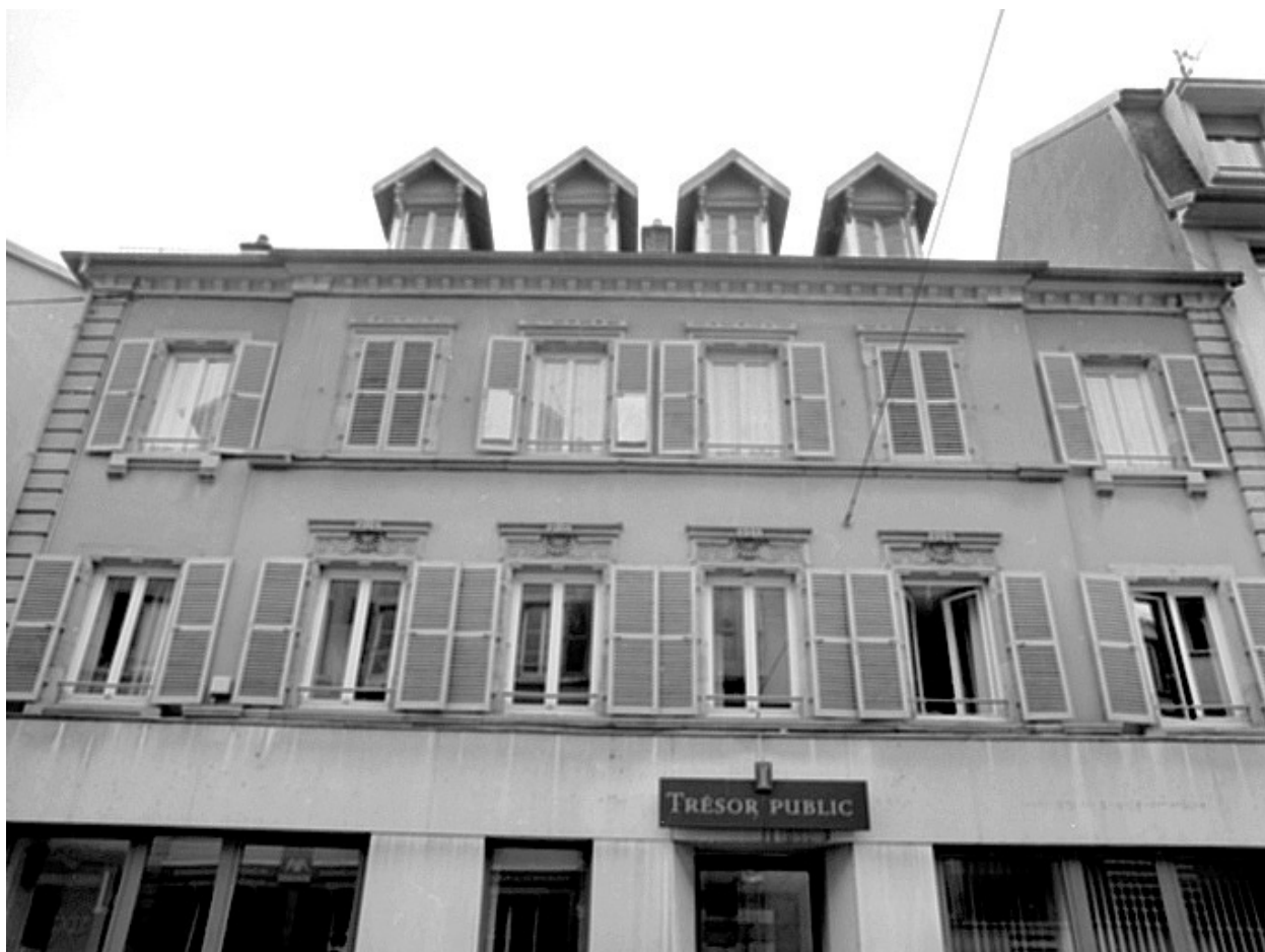
Etages du bâtiment sis au n° 25 (logements ?).
