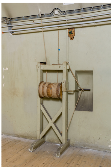
Sous-sol, salle du jeu d'orgue : treuil de commande du rideau de scène. Phot. Pierre-Marie Barbe-Richaud IVR26_20257100340NUC4A
