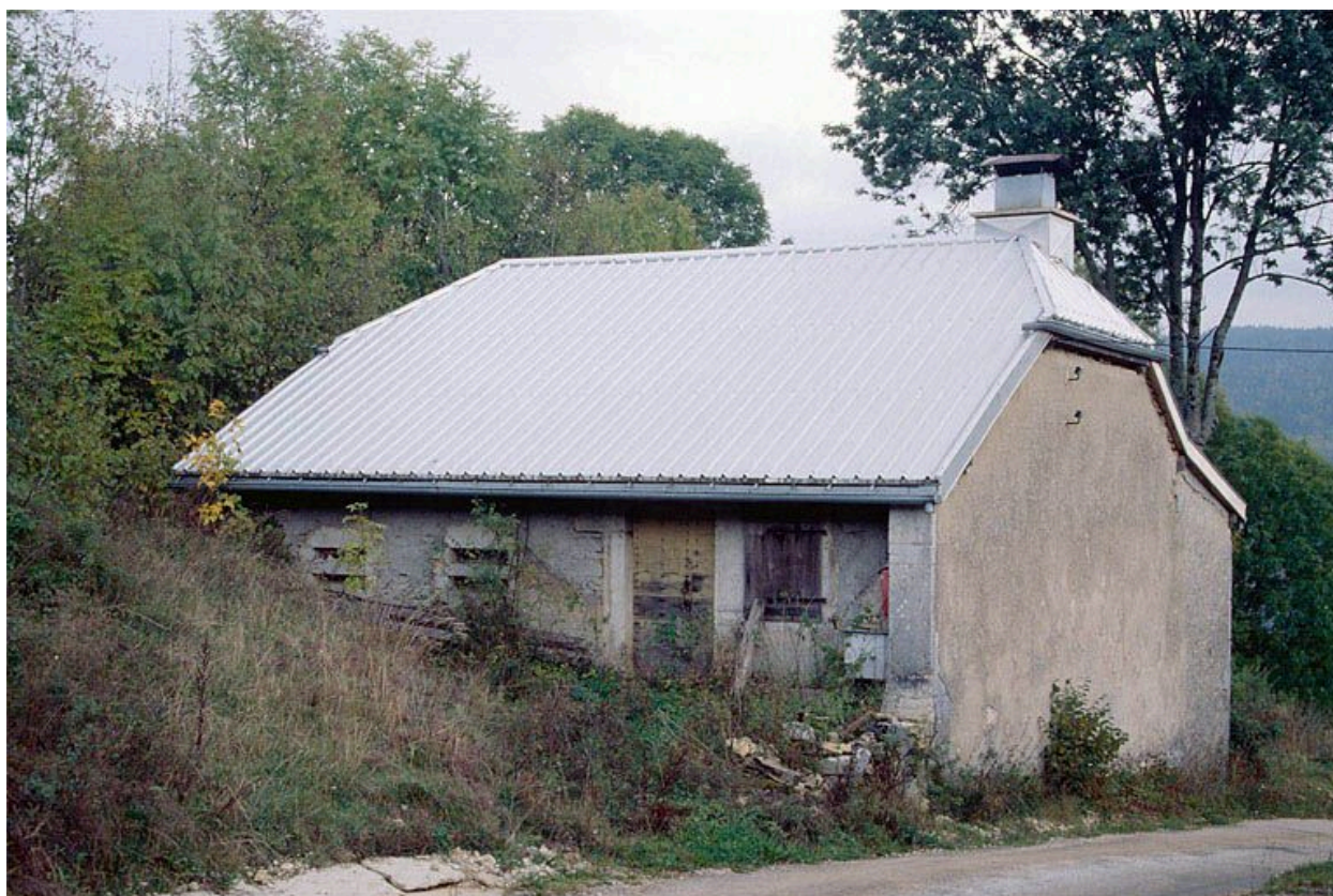
Fromagerie, vue de trois quarts droit.
