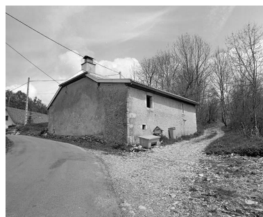
Façade postérieure. Phot. Yves Sancey IVR43_19993900212X
