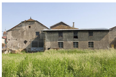
Façades postérieures de la féculerie. Phot. Jérôme Mongreville IVR43_20077000174NUCA
