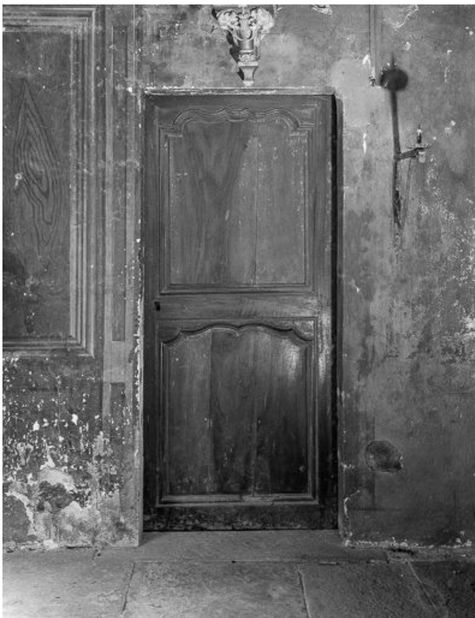
Intérieur : chœur : porte de la sacristie.
