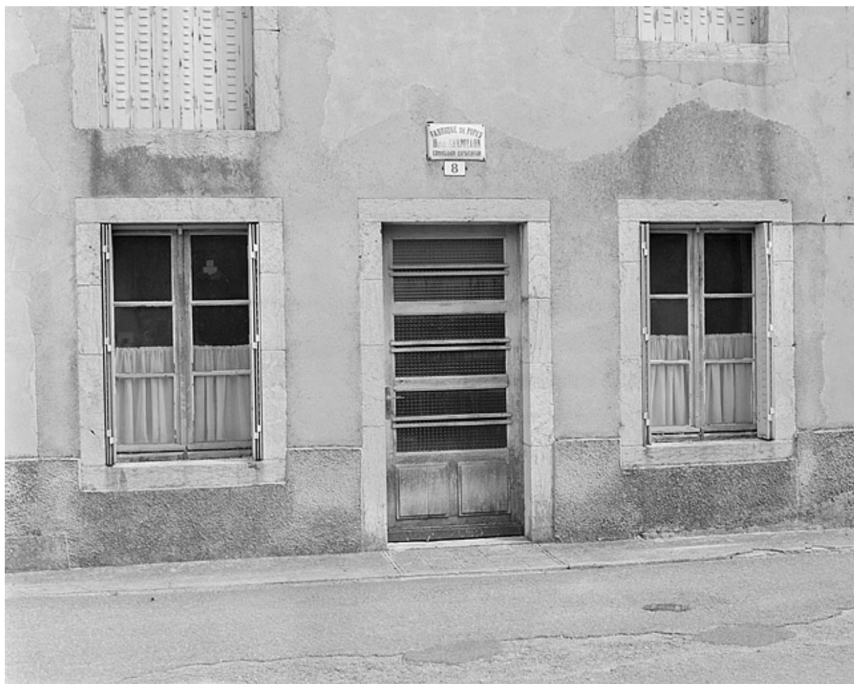
Magasin de vente de l'usine Mermillon.
