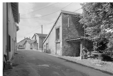
Bâtiment de stockage des ébauchons. Phot. Jérôme Mongreville IVR43_19963901083X
