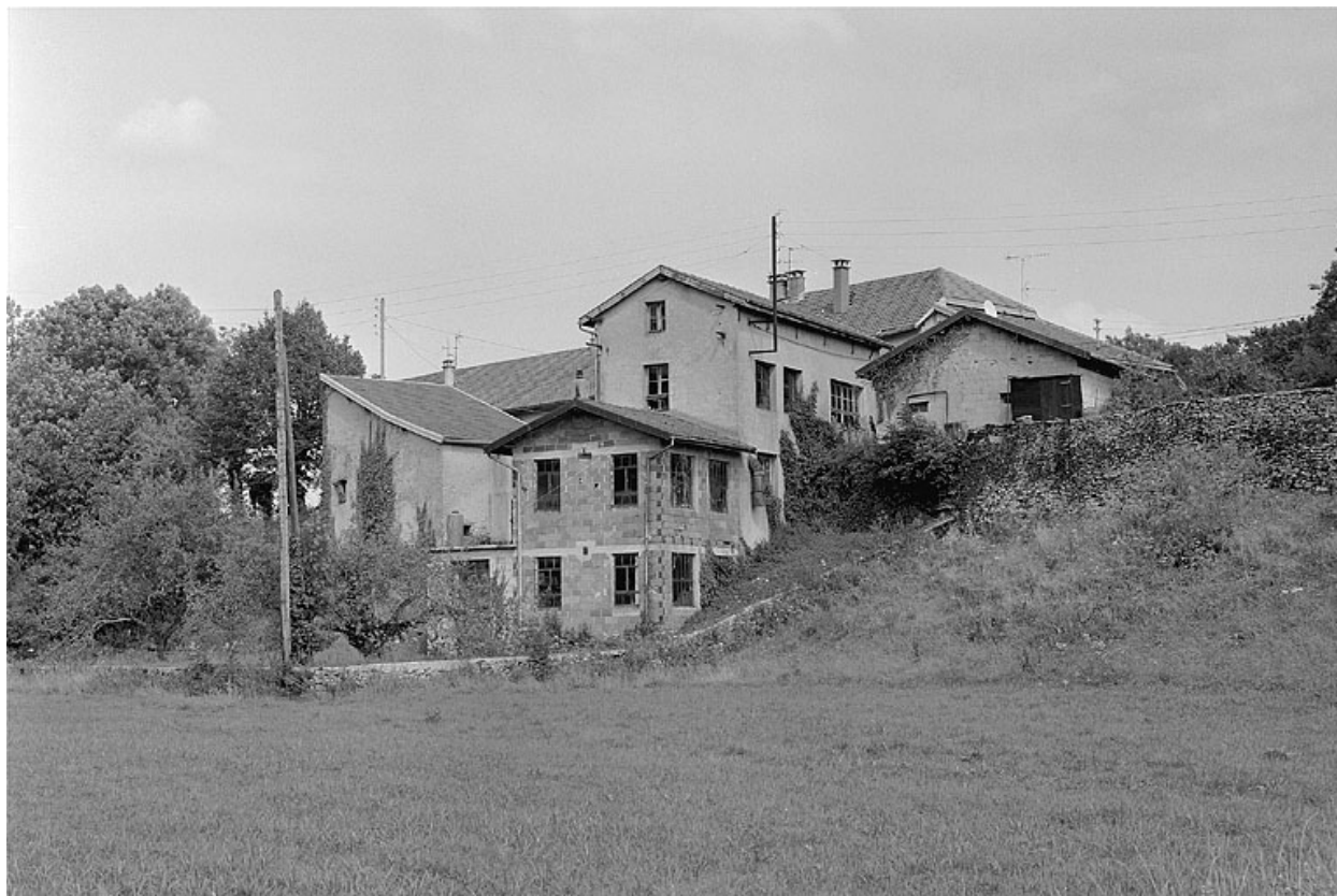
Vue générale de l'atelier.
