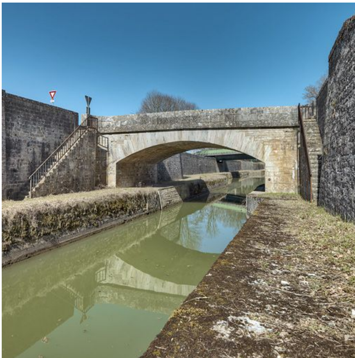
Le pont en pierre de l'amont, avec ses deux escaliers d'accès à la banquette de halage de la tranchée. Derrière le pont plus récent.
