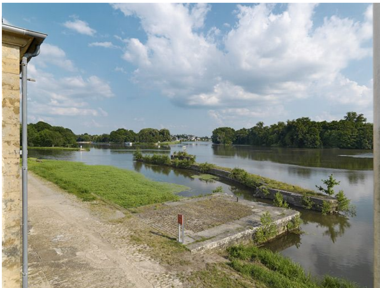
Le quai et le pertuis en maçonnerie de moellon devant le maison. En arrière-plan, la ville de Decize.
