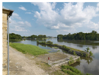
Le quai et le pertuis en maçonnerie
