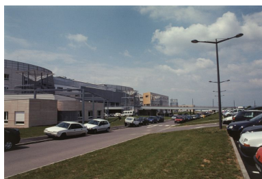
Façade antérieure, vue d'ensemble. Phot. Jean-Luc Duthu IVR26_20035800199ZA
