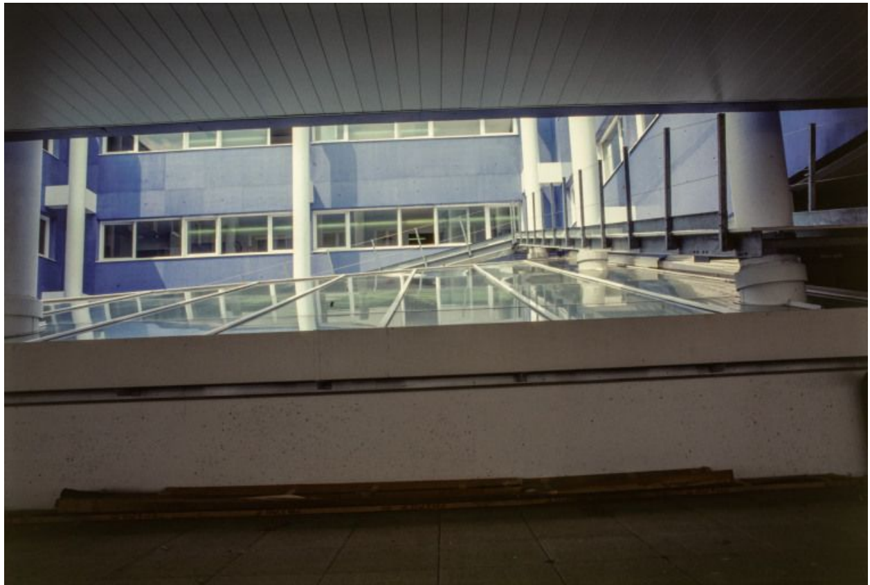
Vue du patio vers les salles d'opération.
