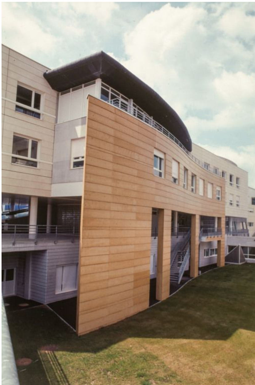
Façade antérieure, détail de la partie gauche.
