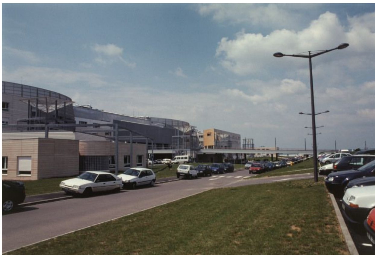
Façade antérieure, vue d'ensemble.
