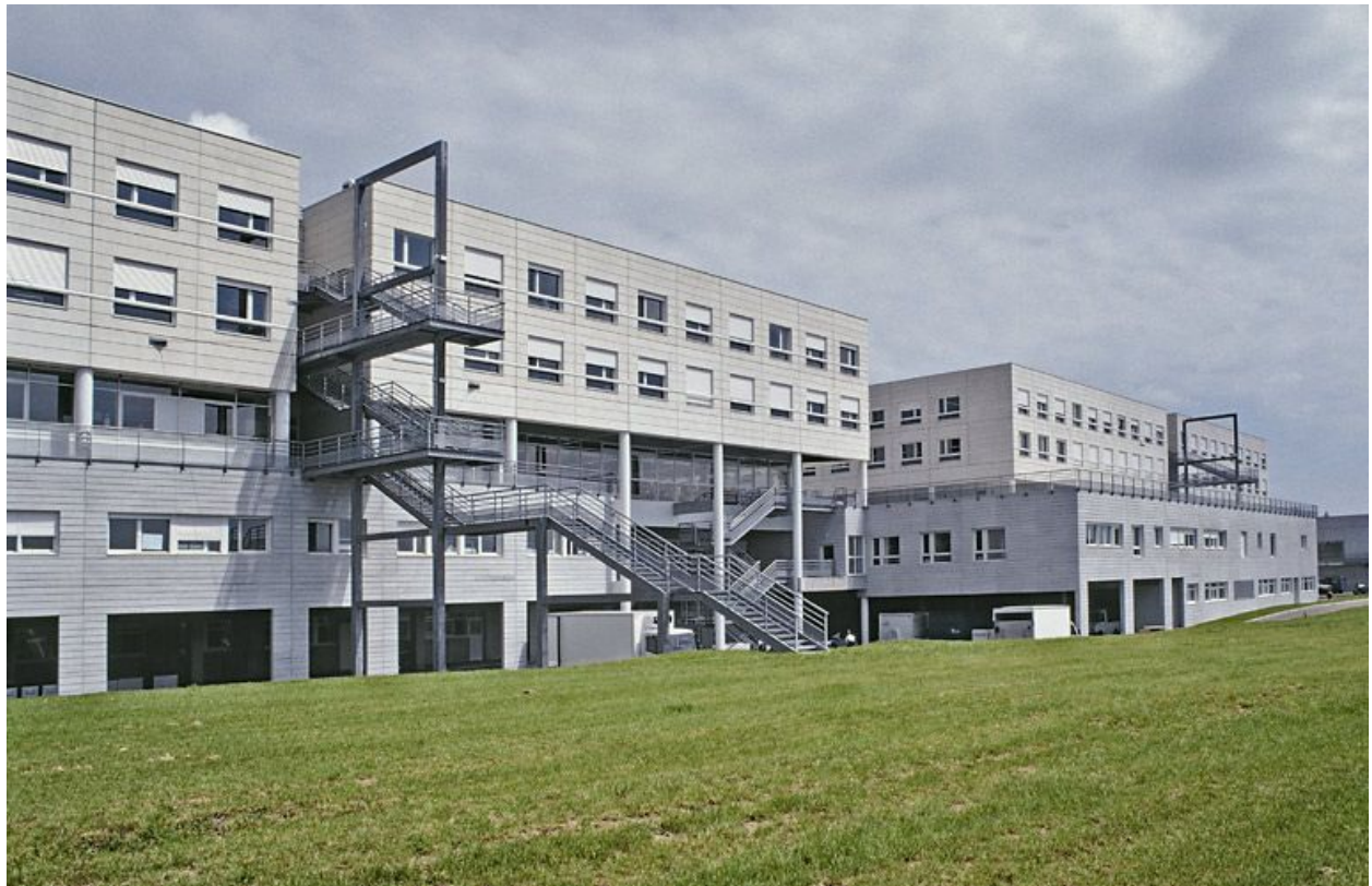
Façade postérieure, partie droite.
