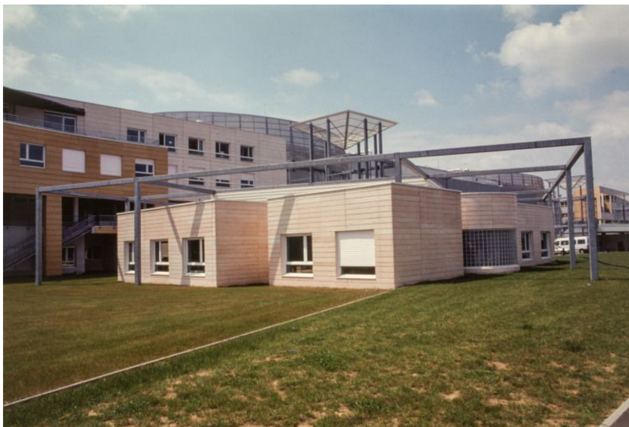
Bâtiment de l'administration.
