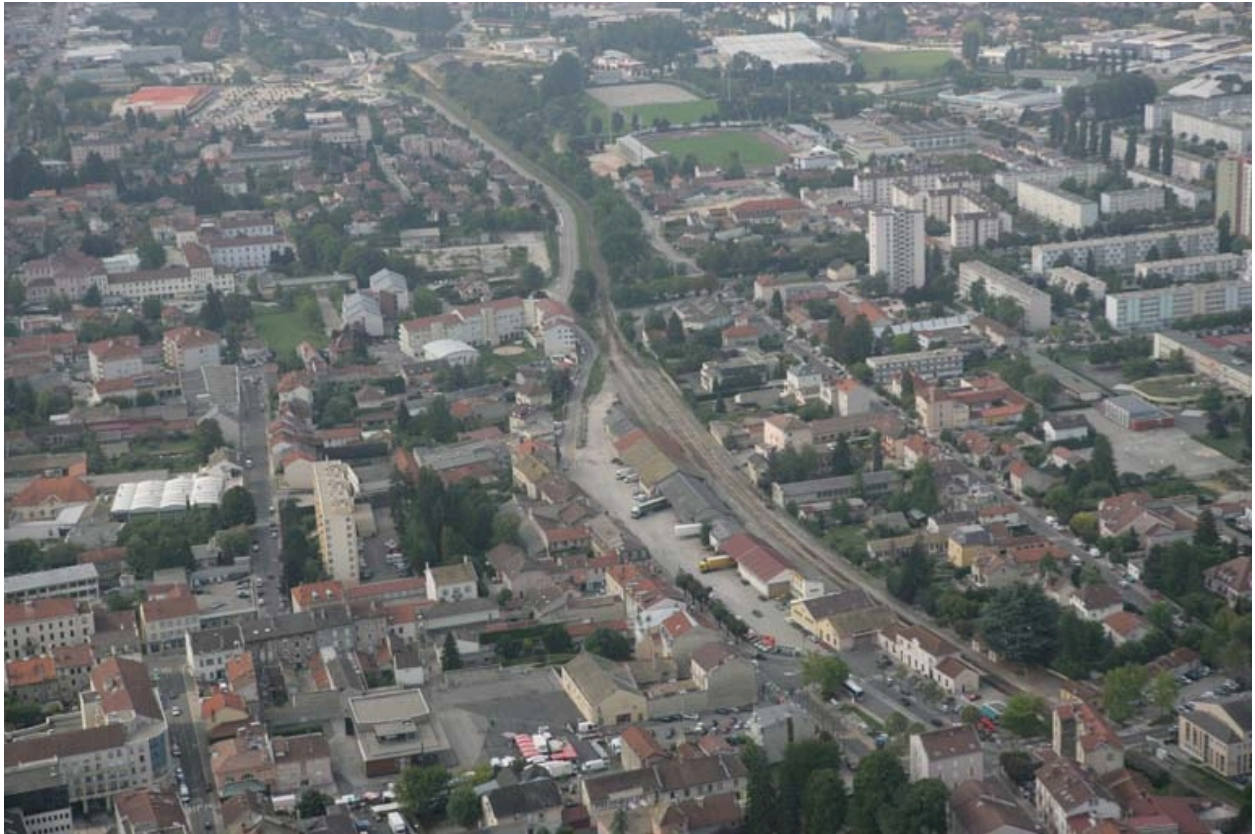
Vue aérienne du site, depuis le nord.
