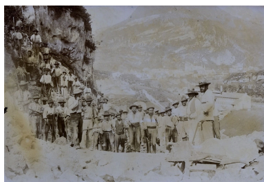
Construction de la ligne de chemin de fer Oyonnax St Claude [ouverture]
