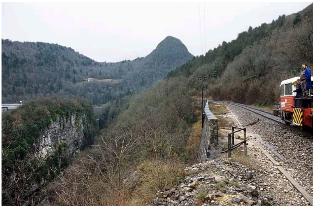
Draisine sur la voie au niveau d'Etables et du Plan d'Acier, commune de Saint-Claude. La Bienne coule au fond de la gorge, à gauche.
