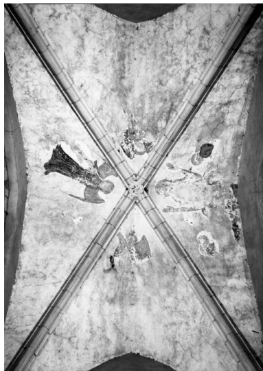
Vue générale Phot. Michel Rosso IVR26_19852101770V
