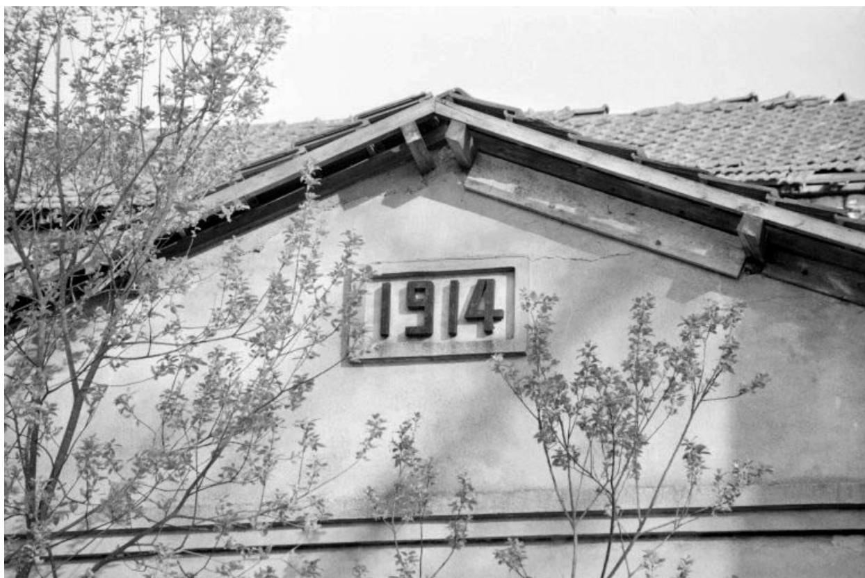
Forge Neuve. Centrale électrique : détail du mur pignon de la salle des machines (J).
