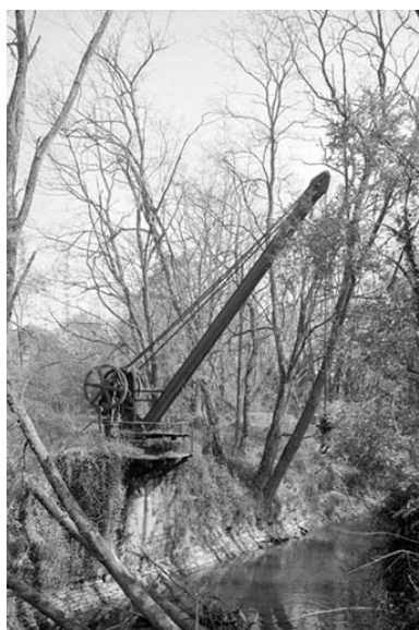
Forge Neuve. Le port : grue (M). Phot. Laurent Poupard IVR43_19883900322Z
