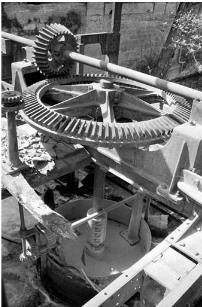
Vieille Forge. Bâtiment d'eau dit le Sénat : détail d'une turbine et de ses engrenages.
