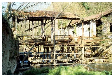
Vieille Forge. Bâtiment d'eau dit le Sénat : salle des turbines vue du canal de fuite. Phot. Laurent Poupard IVR43_19883900327ZA
