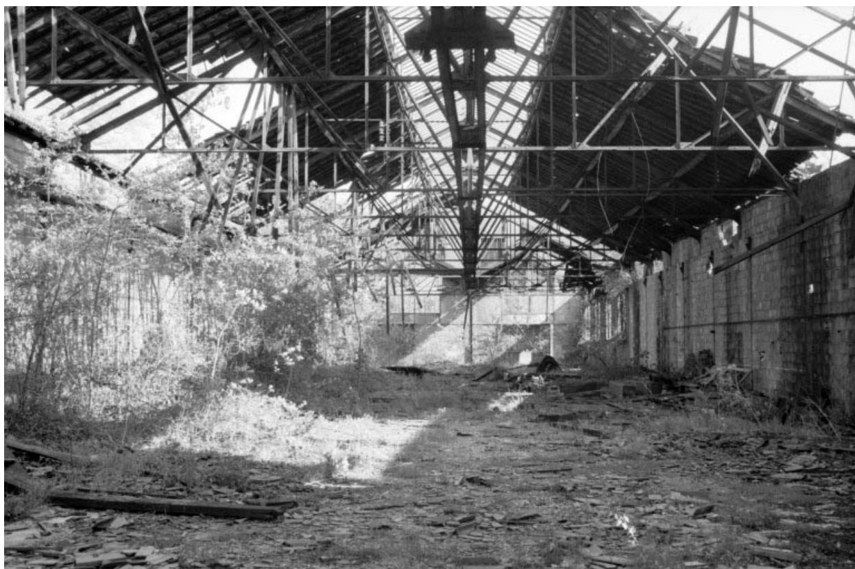
Forge Neuve. Atelier de construction : intérieur.
