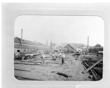
Ouvriers au travail entre l'atelier de construction (à gauche) et la cité ouvrière (à droite), à la fin du 19e siècle. Phot. Yves Sancey, Phot. De Jongh Frères IVR43_19883900211V
