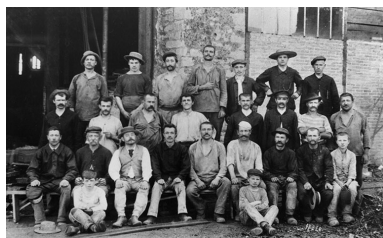
Une équipe de l'atelier de construction. Phot. Yves Sancey IVR43_19883900198V
