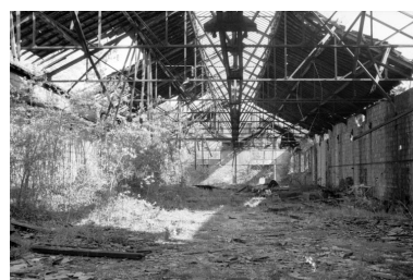
Forge Neuve. Atelier de construction : intérieur. Phot. Laurent Poupard IVR43_19883900315Z
