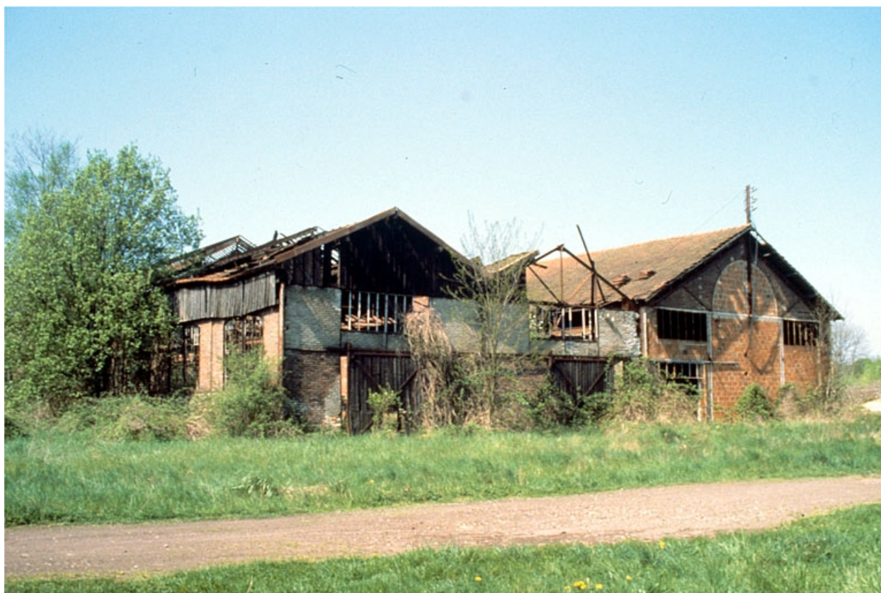
Forge Neuve. Atelier de construction : façade antérieure.
