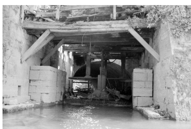
Forge Neuve. Bâtiment d'eau (L) : chambre d'eau et turbine vues du canal de fuite. Phot. Laurent Poupard IVR43_19883900310Z
