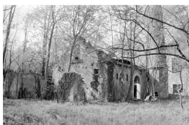
Forge Neuve. Bâtiment d'eau (L) vu de trois quarts gauche. Phot. Laurent Poupard IVR43_19883900309Z
