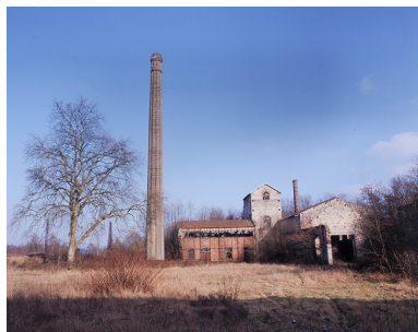
Forge Neuve. Centrale électrique, monte-charge du haut-fourneau et fonderie.
