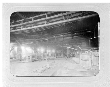
Intérieur du bâtiment de la Forge Neuve, à la fin du 19e siècle : laminoirs (à tôle ?) et fours (à souder ?). Phot. Yves Sancey, Phot. De Jongh Frères IVR43_19883900218V
