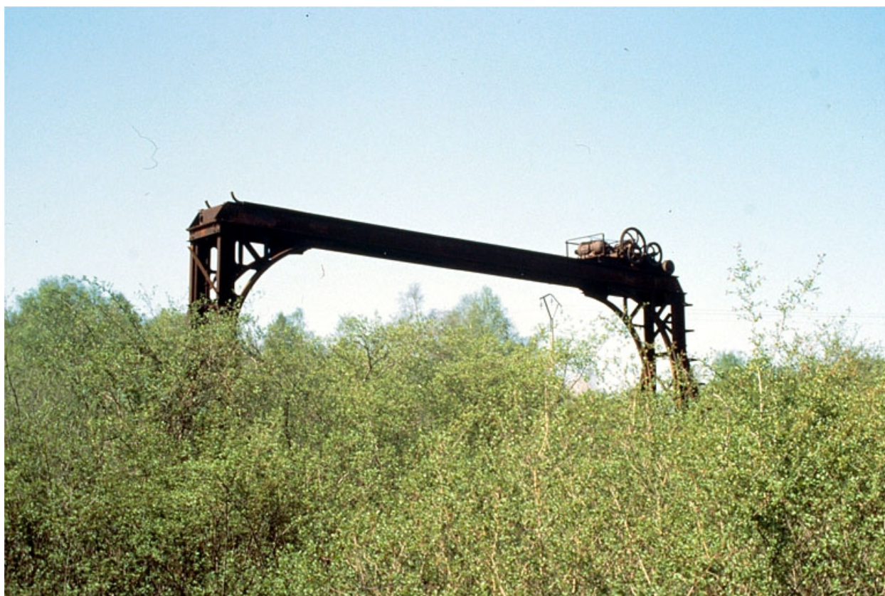
Forge Neuve. Portique roulant.
