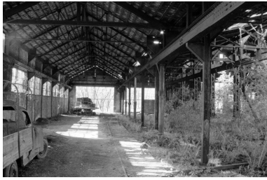
Forge Neuve. Atelier de construction : intérieur (vaisseau sud-ouest). Phot. Laurent Poupard IVR43_19883900316Z
