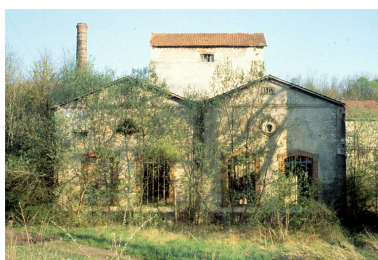
Forge Neuve. Centrale électrique : salle des machines (J). Phot. Laurent Poupard IVR43_19883900303ZA
