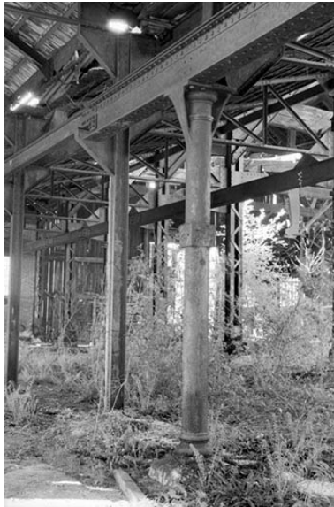
Forge Neuve. Atelier de construction : détail d'un poteau. Phot. Laurent Poupard IVR43_19883900317Z
