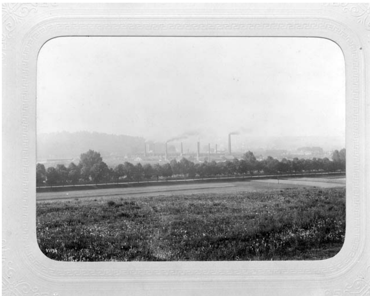
Vue d'ensemble de la Forge Neuve depuis le nord, à la fin du 19e siècle.
