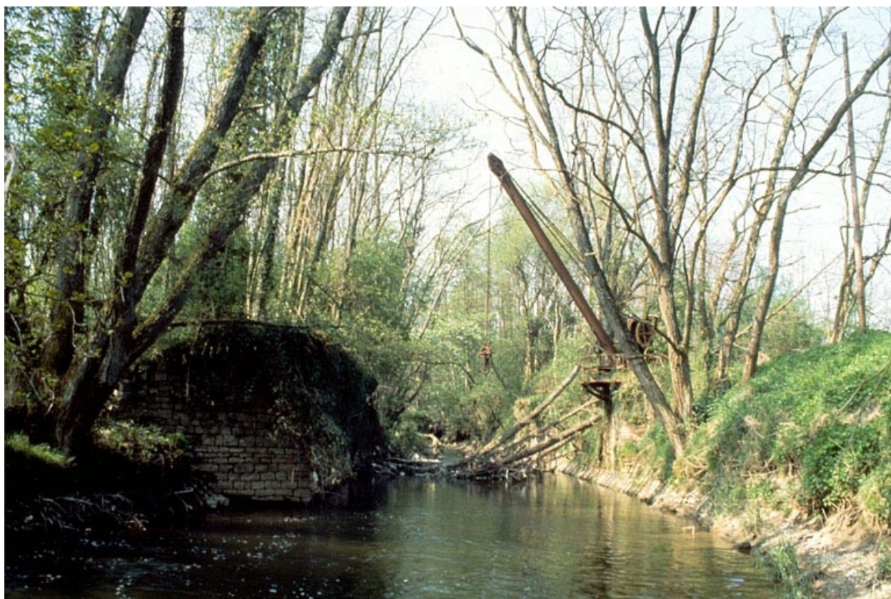
Forge Neuve. Le port (N) : entrée du canal.
