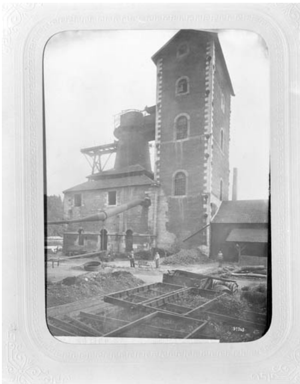
Le haut-fourneau vu du nord, à la fin du 19e siècle.
