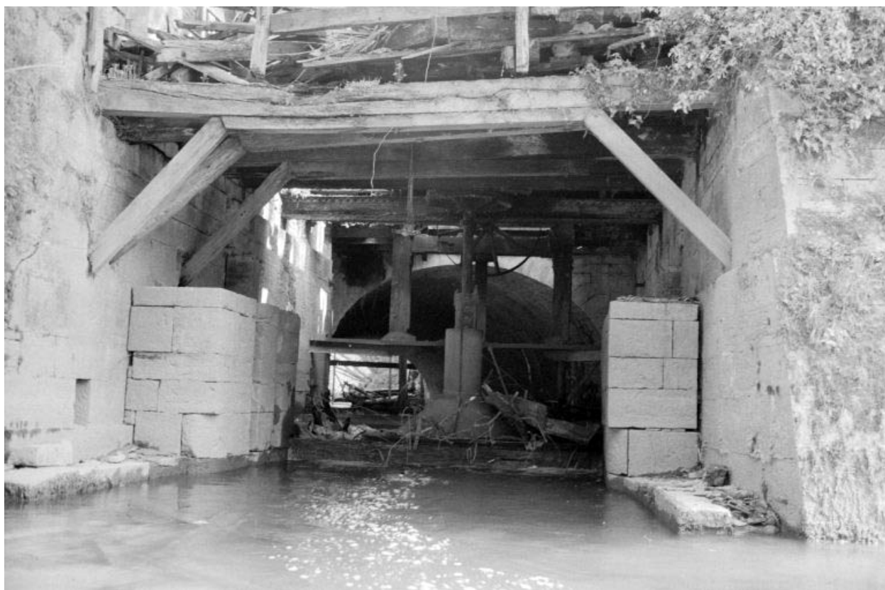
Forge Neuve. Bâtiment d'eau (L) : chambre d'eau et turbine vues du canal de fuite.
