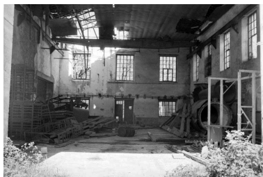
Forge Neuve. Centrale électrique : intérieur de la salle des machines H (ancien bâtiment du haut-fourneau). Phot. Laurent Poupard IVR43_19883900306Z
