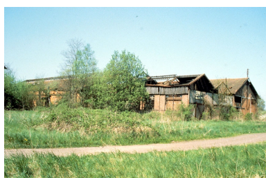
Forge Neuve. Atelier de construction (O) vu de trois quarts gauche. Phot. Laurent Poupard IVR43_19883900313ZA
