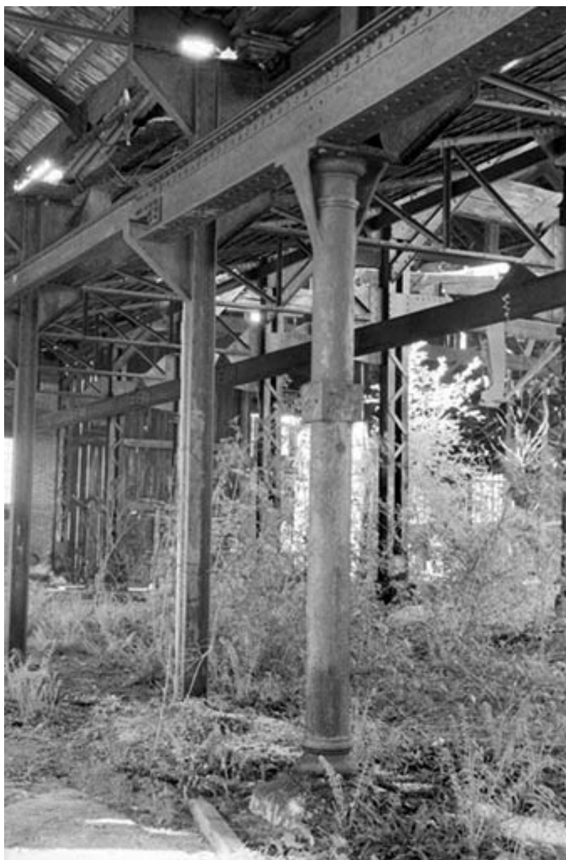
Forge Neuve. Atelier de construction : détail d'un poteau.
