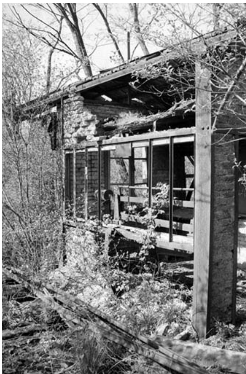
Forge Neuve. Bâtiment du pont-bascule (P).
